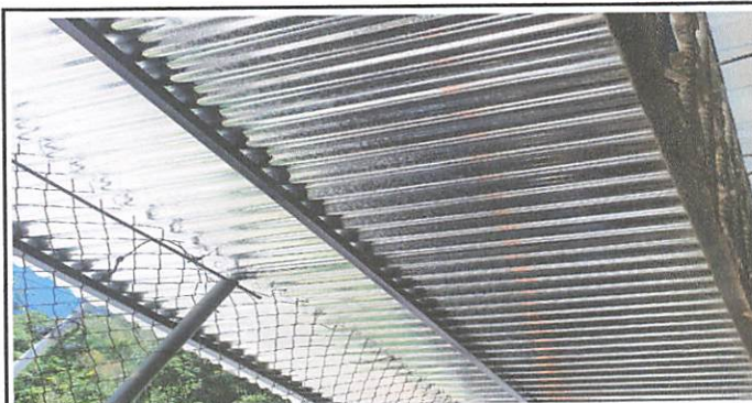
Foto 4: Techado de la pila
