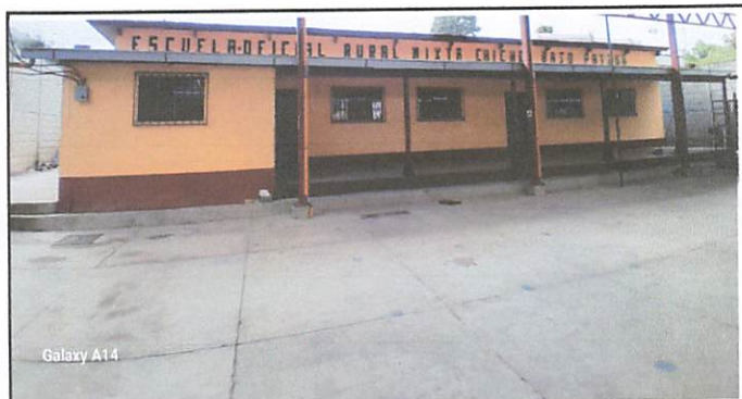
Foto 6: Pintada de dos aulas, dirección y corredor
