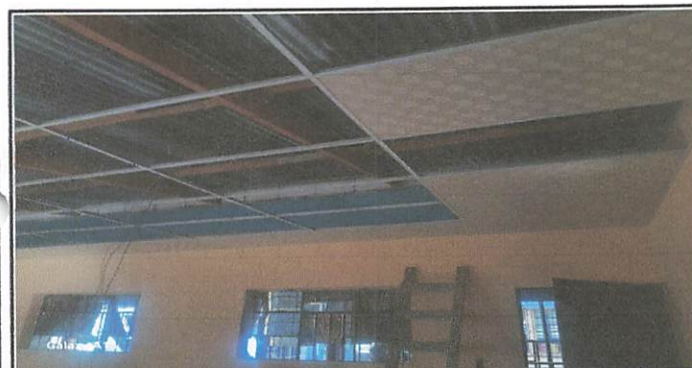
Foto 5: Avance del cielo falso
