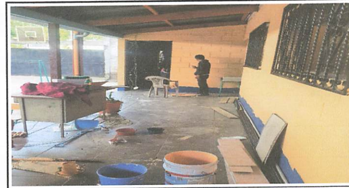
Foto 6: Avance de la pintada de paredes
