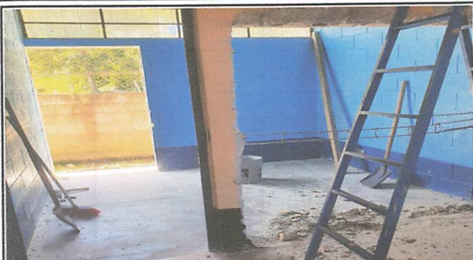
Foto 1: Avance de la ampliación y traslado de marco de la puerta
