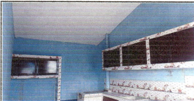
Foto 12: GABINETES AEREOS DE CONCRETO, CON PUERTAS DE METAL, TERMINADOS Y ENTREGADOS
