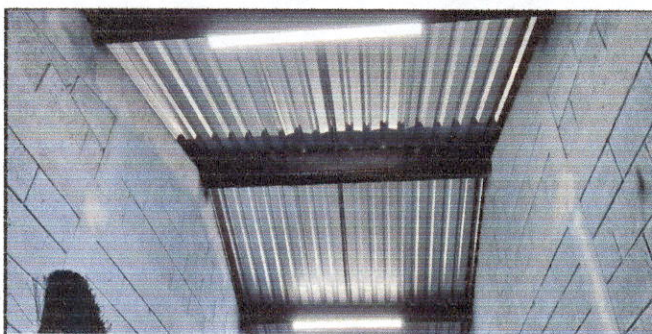
Foto 4: ILUMINACION LISTA Y FUNCIONANDO EN LOS SANITARIOS
