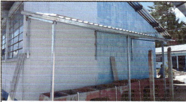
Foto 9: TECHADO DE PILAS TERMINADO
