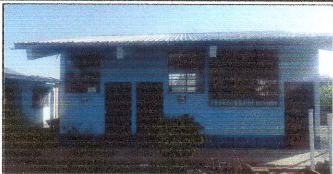
Foto1: TECHO DEL MODULO I, SANITARIOS Y DIRECCION TERMINADO
