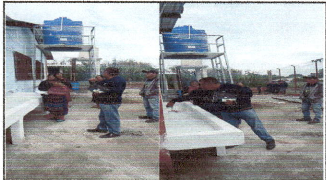
Foto 8: PILETA CON CHORROS LISTA Y BASE PARA TINACO Y TINACO INSTALADOS Y TERMINADOS
