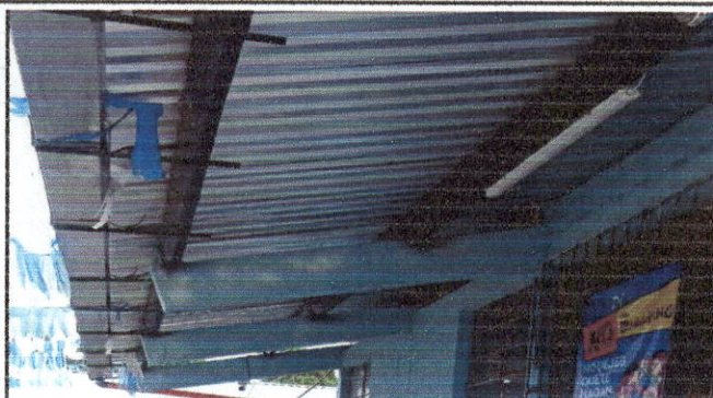
Foto 2: COSTANERAS REMOZADAS, CANALES NUEVOS INSTALADOS E ILUMINACION COLOCADA.
