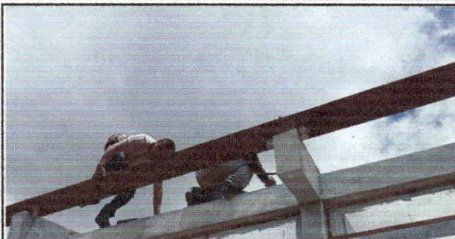
Foto 2: MANTENIMIENTO PREVENTIVO Y CORRECTIVO DE TENDALES Y COSTANERAS
