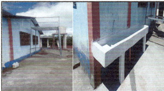
Foto 8: CONSTRUCCION DE BASE PARA TINACO Y CONSTRUCCION DE PILETA CON CHORROS
