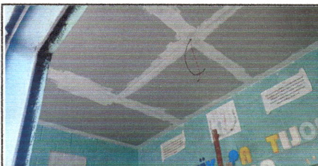
Foto 6: COLOCACION DE CIELO FALSO E ILUMINACION EN LA DIRECCION, MODULO I
