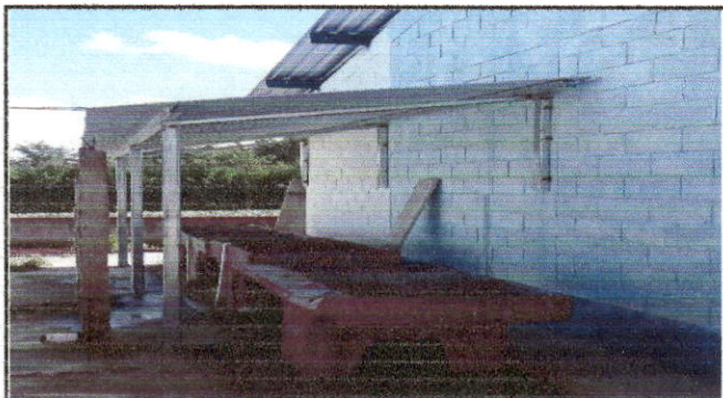
Foto 9: TECHADO DE PILAS
