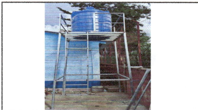
Foto 10: CONSTRUCCION DE BASE PARA TINACO Y COLOCACION DE TINACO QUE ALIMENTARA DE AGUA A LA COCINA
