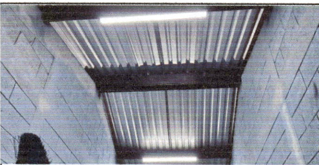
Foto 5: PRUEBA DE ILUMINACION DE LOS SANITARIOS Y TECHADO MODULO I
