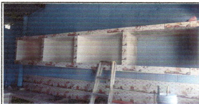
Foto 11: CONSTRUCCION DE GABINETES AREOS EN LA COCINA
