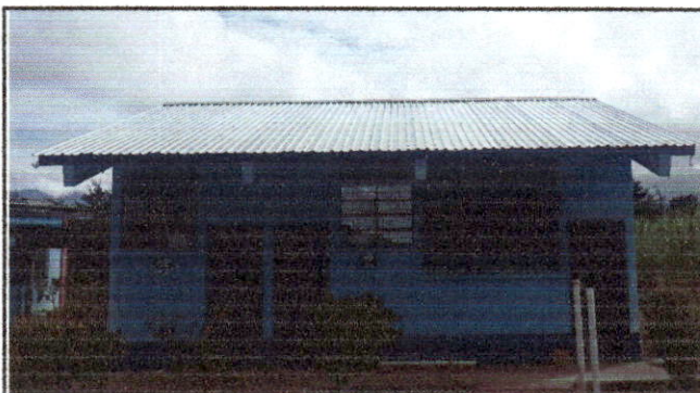
Foto 4: COLOCACION DE LAMINAS NUEVAS EN TECHADO DE SANITARIOS, DIRECCION Y CORREDOR MODULO I
