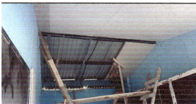
Foto 12: COLOCACION DE CIELO FALSO E ILUMINACION EN LA COCINA.
