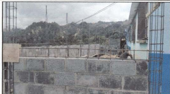
Foto 1: Este sería la parte frontal de la nueva cocina.
