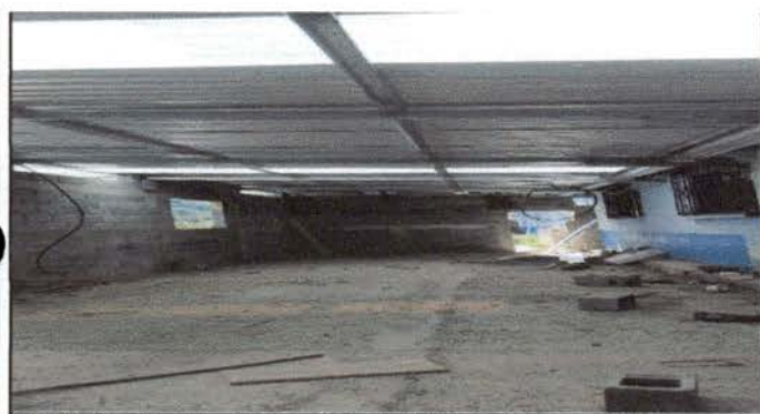
Foto 5: Ya colocado el techo y la torta del piso, obra concluida.
