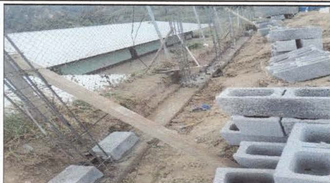
Foto 2: Las bases ya colocadas listas para colocar las paredes.
