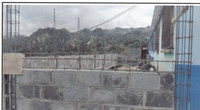
Foto 4: Las paredes estan al 40 % y avanzando.
