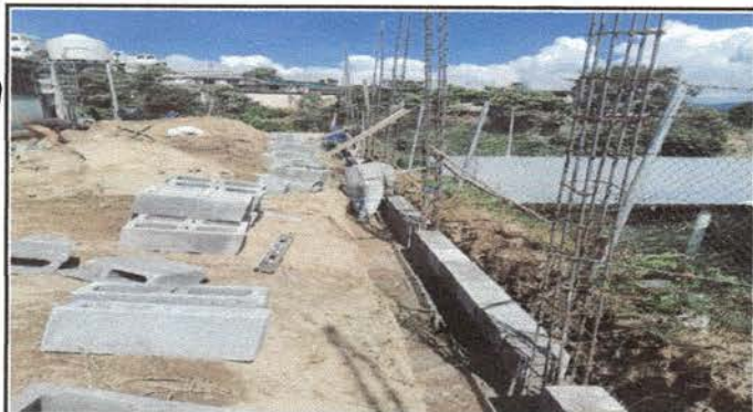
Foto 3: Los albañiles trabajando proceso arduo.
