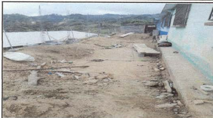
Foto1: Area ya intervenida e iniciando los trabajos colocados las columnas.
