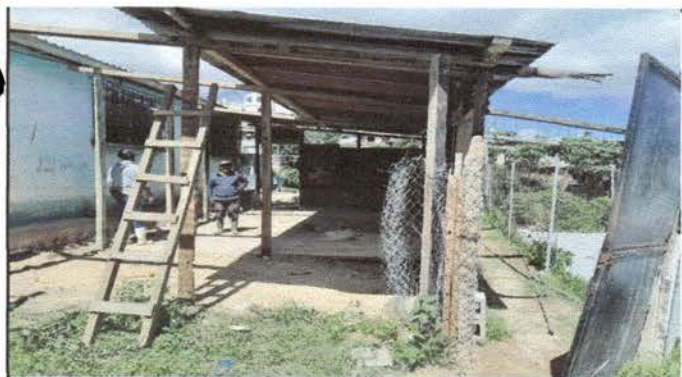
Foto 3: Espacio en destruccion de la galera para iniciar los trabajos de cocina.
