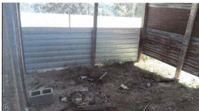
Foto 4: Espacio de ampliacion de la cocina.
