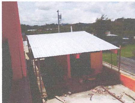
Foto 6: Techo de cocina y corredor
