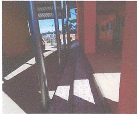
Foto 2: Colocacion de piso en gradas primer nivel
