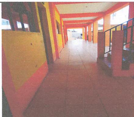
Foto 3: Colocacion de piso en corredor primer nivel.
