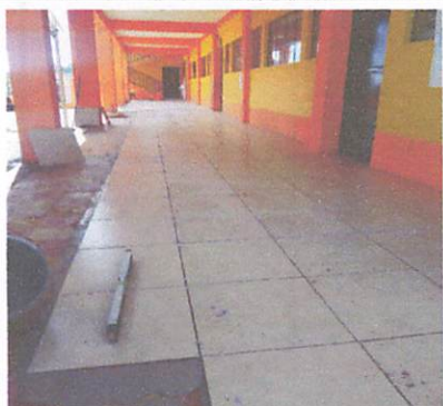
Foto 3: Colocacion de piso en corredor primer nivel.
