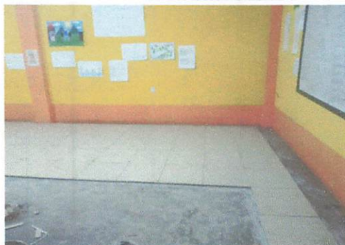
Foto 1: Colocacion de piso en salon segundo nivel.
