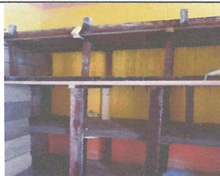
Foto 4: Proceso de construccion de trinchante permanente
