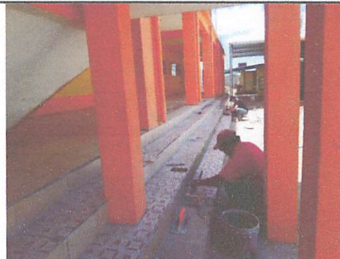
Foto 2: Colocacion de piso en gradas primer nivel
