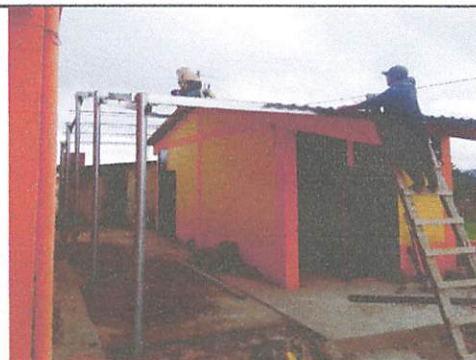
Foto 6: Techo de cocina y corredor
