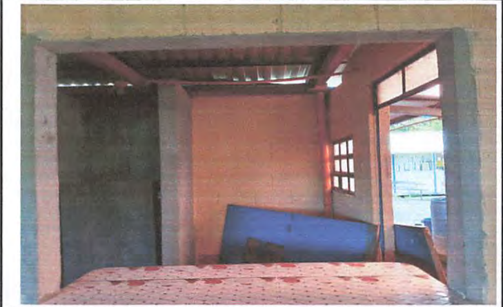
Se hizo la abertura de pared y tallado del mismo se refiere al area de cocina consta de 1.7 mts cuadrados
