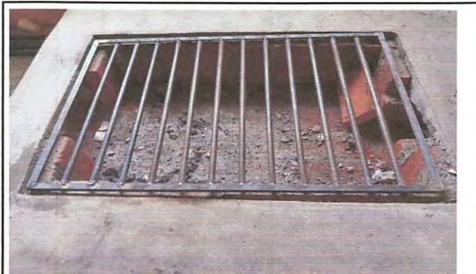
Se fabricó y se hizo la instalación de 6 bases metálicos para pollos de cocina con medidas de 91.5 cm por 65 cm
