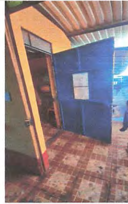
Se cambió de posición, cambio de lado de chapa y tipo de abertura
