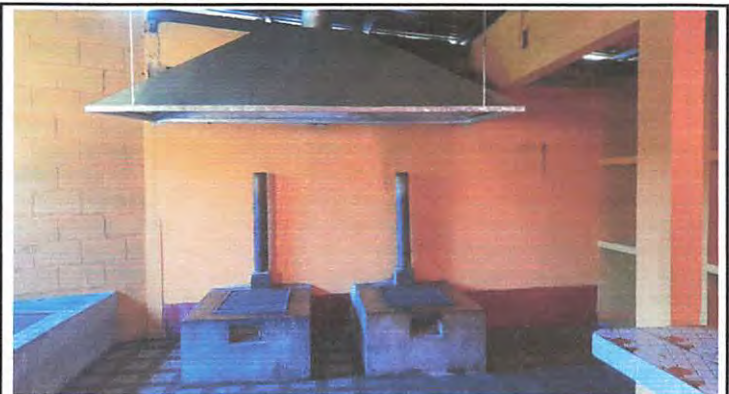
Se fabricó e instalación de una campana metálica grande con medidas de 1.65 de ancho por 3 mts de largo
