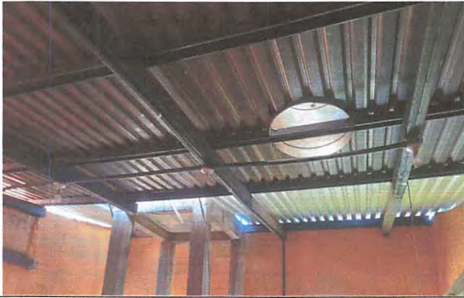
Se remodeló la instalación de 4 cajas octagonales, instalacion de 4 cajas
