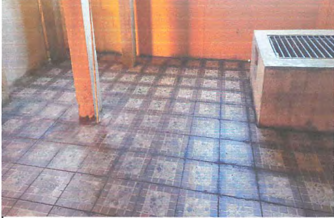
Se emparejó, se rellenó y se pavimentó por aumento de cocina 14 metros cuadrados
