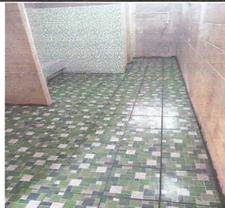
Se realizó el picado y colocación de piso cerámico en sanitario de hombres 19 mtrs
