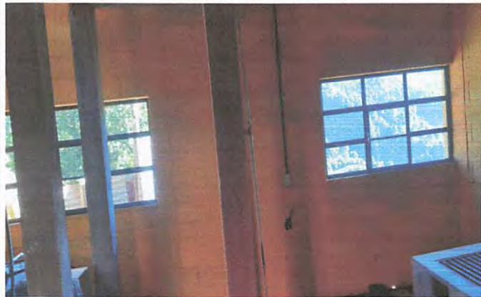
Se fabricó y se hizo la instalación de ventanas metálicas abatibles
