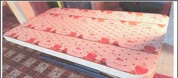
Se le colocó azulejo en mesa de concreto de 2 metros cuadrados
