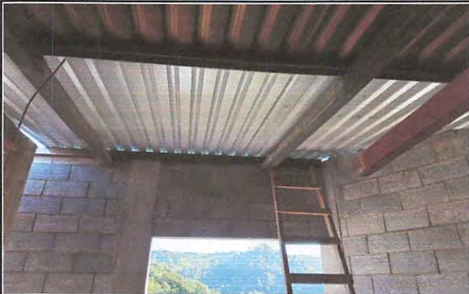
Se realizó nueva armazón metalico y enlaminado de techado por aumento
