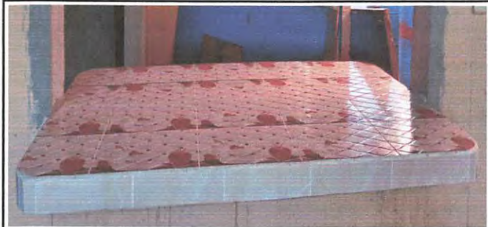
Se hizo la amazon, emparrillado y fundición mesa de concreto, se refiere al area de cocina donde se hizo la abertura de pared consta de 1 mt cuadrado
