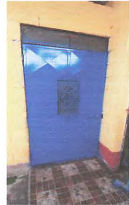
Se cambió de posición, cambio de lado de chapa y tipo de abertura
