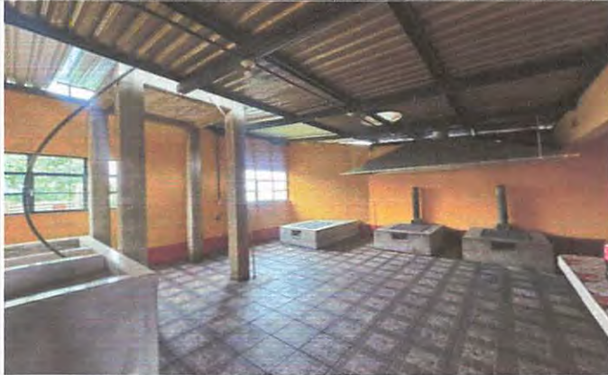
Se pintó a doble mano la pintada de cocina
