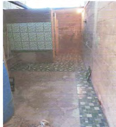
50% de avance de picado y colocación de piso cerámico en sanitario de
