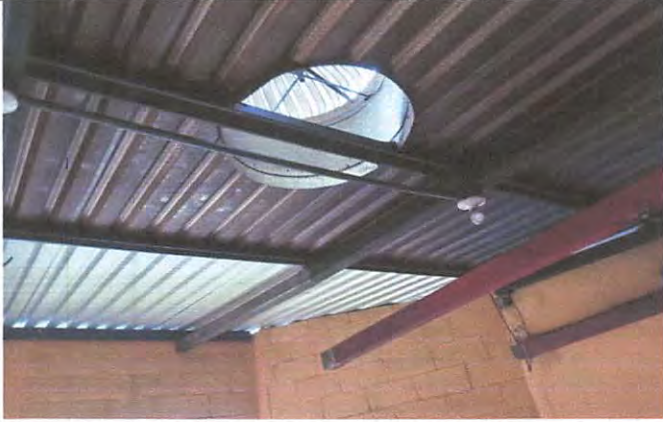
80% de avance de remodelación, instalación de 4 cajas octogonales,
