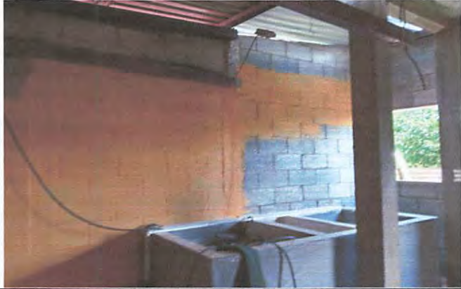
50% de avance de pintura a doble mano en cocina
