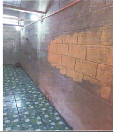
50% de avance de pintura a doble mano en sanitario
