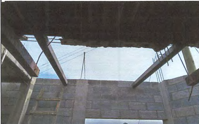
50% de avance de armazón metálico y enlaminado de techado por
