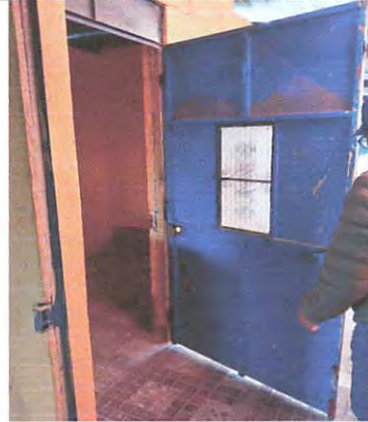
90% de avance de cambio de posición, cambio de lado de chapa y tipo
