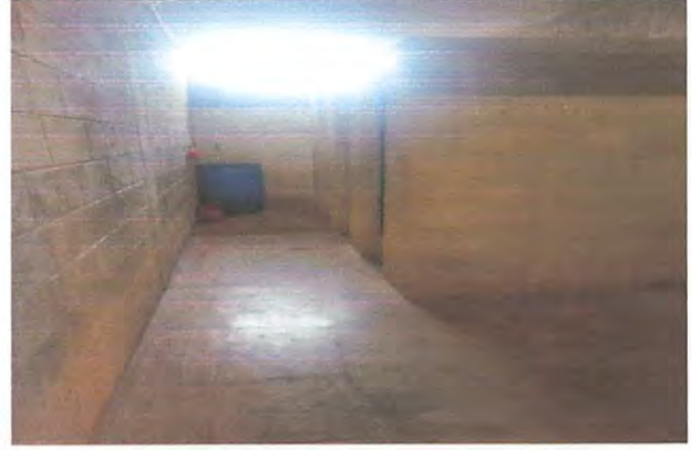
Pintura a doble mano en sanitario
