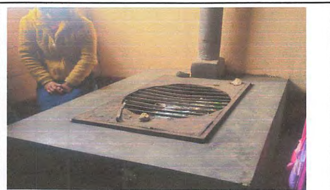
Fabricación e instalación de 6 bases metálicas para pollos de cocina con medidas de 91.5 cm por 65 cm
