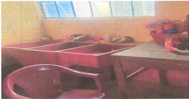
Elaboración de pila de 1 mt de ancho, por 2.40 mts de largo y 90cm de altura con 2 lavaderos aéreos, Cada lavadero de 1 mt de largo y 95 cm de ancho y una abertura entre lavadero de 50 cm, con su depósito de agua con capacidad de 2.5
