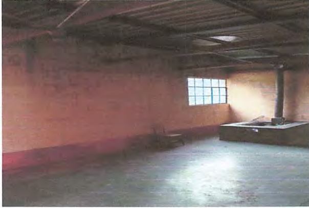
Pintura a doble mano en cocina
