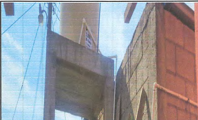
Armazón metalico y enlaminado de techado por aumento de cocina
