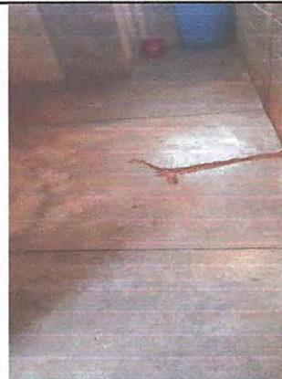
Picado y colocación de piso cerámico en sanitario de hombres 19 mtrs
