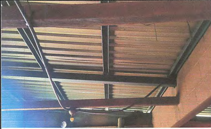
Remodelación, instalación de 4 cajas octagonales, instalacion de 4
