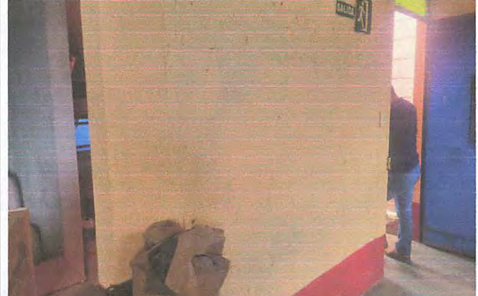
Abertura de pared y tallado del mismo se refiere al area de cocina consta de 1.7 mts cuadrados
