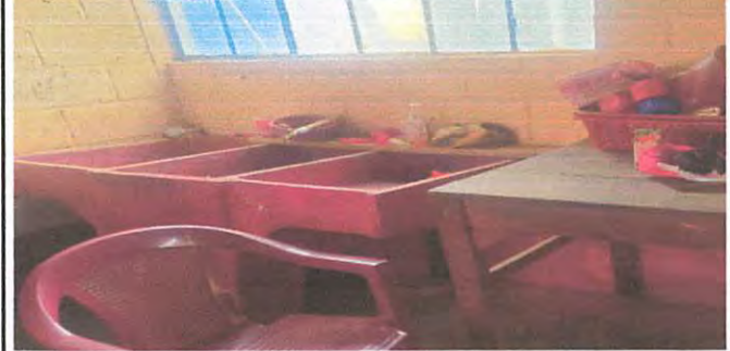
Colocación de azulejo en interior de la pila, que consta de 6 metros cuadrados. Se habla de la pila nueva que se va a elaborar.
