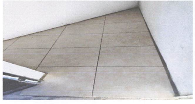
Foto 2: Reparación de la bodega de la cocina. Así quedó
