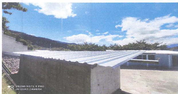
Foto7: Cambio del techado de los sanitarios. Asi quedó
