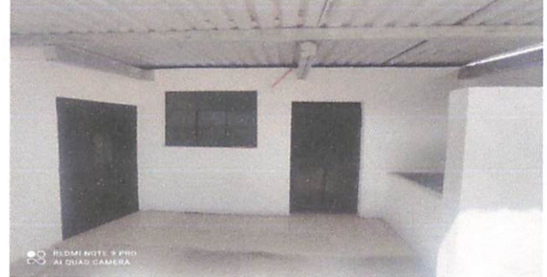
Foto 6: Repello de paredes. Así quedó
