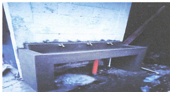
Foto 8: Instalación de lavamano lado derecho. Asi quedó
