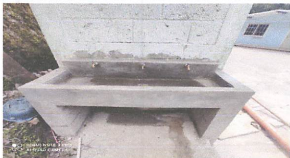
Foto 9: Instalación de lavamos de sanitarios lado izquierdo. Asi quedó
