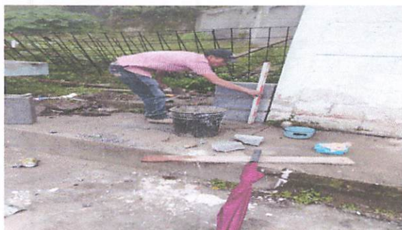
Foto 3: Instalación de lavamanos de sanitario lado izquierdo.
