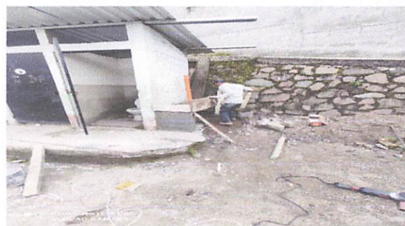
Foto 2: Instalación de lavamanos lado derecho
