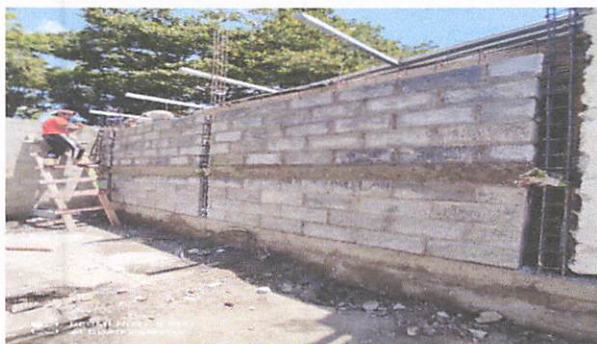
Foto 1: Cambio de pared de cocina
