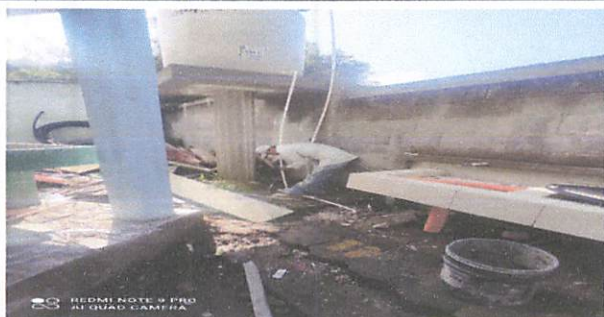
Foto 5: Instalación de deposito de agua.
