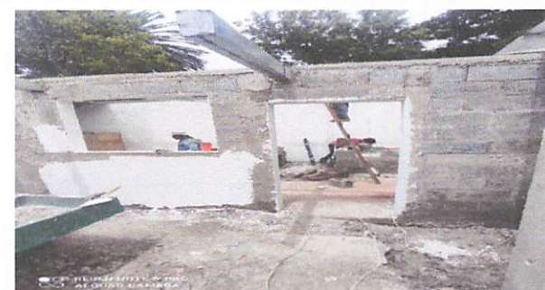
Foto 6: Repello de paredes
