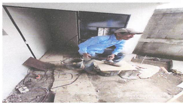
Foto 2: Reparación de la bodega de cocina
