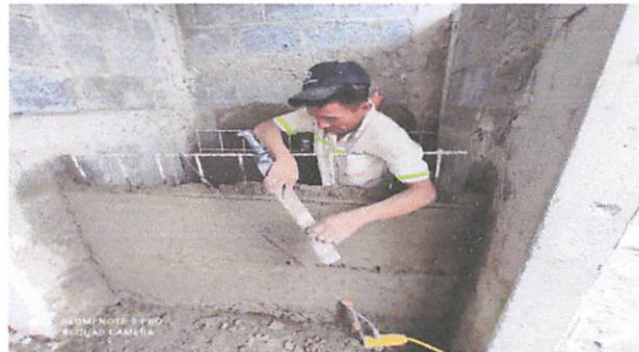
Foto 4: Reparación de Pila con lavadero
