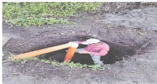
Foto 6: instalación de tubería de drenaje
