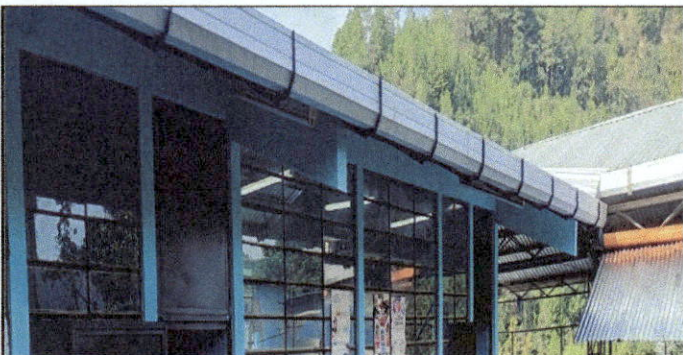
Foto 5 : canales y bajadas nuevos.
