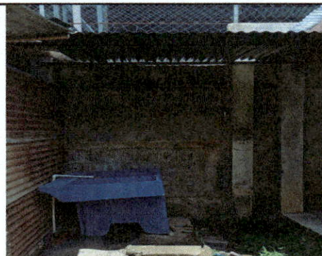
Foto 4: intalacion de pila nueva y techado.
