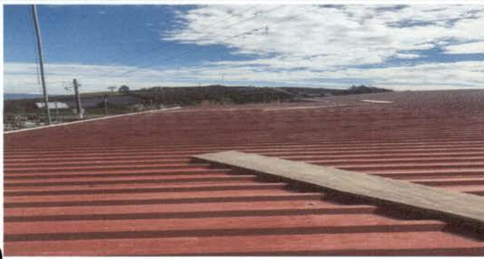
Foto 1: Sustitución de lamina por deterioro y filtracion de agua y costanera.
