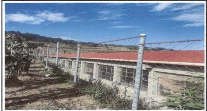
Foto 4: Sustitución de lamina por deterioro y filtración de agua y costanera.
