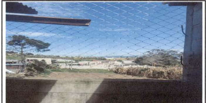
Foto 6: Sustitución de mallas por deterioro.
