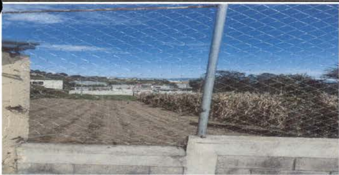
Foto 5: Sustitución de mallas por deterioro.
