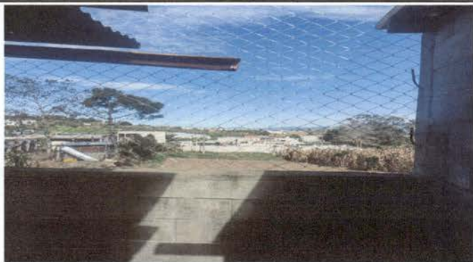
Foto 3: Sustitución de mallas por deterioro.
