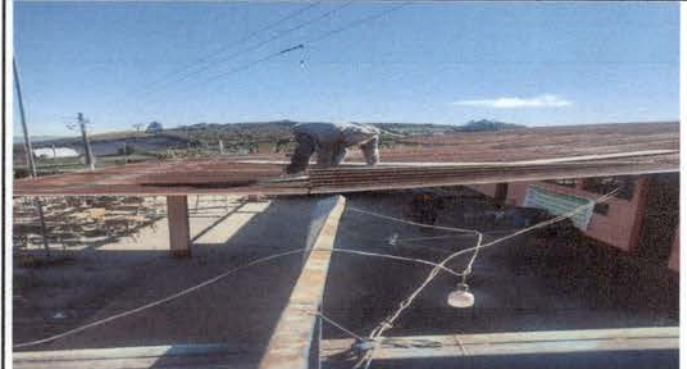
Foto 2: Sustitución de lamina por deterioro y filtracion de agua y costanera.
