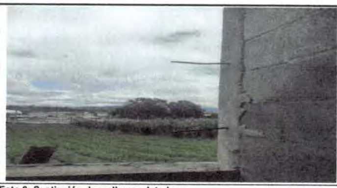
Foto 6: Sustitución de malla por deterioro
