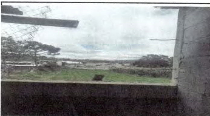
Foto 3: Sustitución de malla por deterioro
