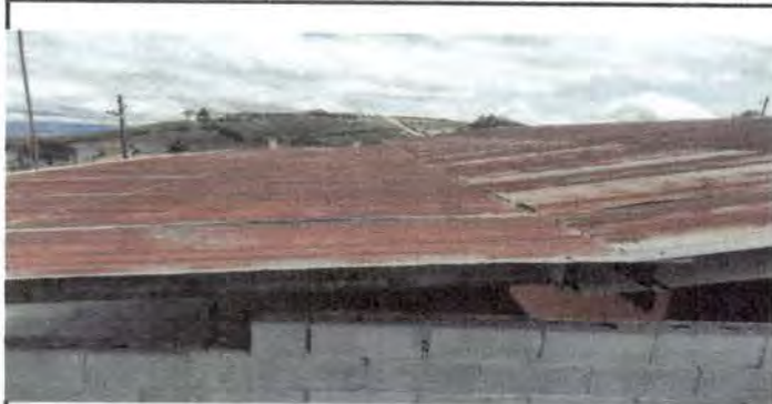
Foto 1: Sustitución de láminas por deterioro y filtración de agua y costanera
