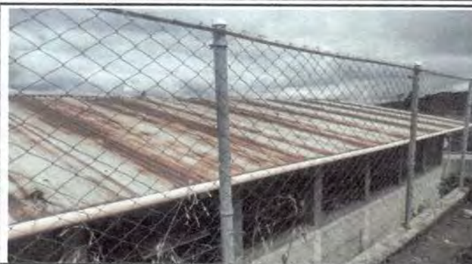
Foto 2: Sustitución de láminas por deterioro y filtración de agua y costanera
