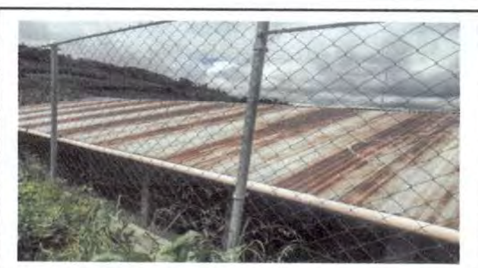
Foto 4: Sustitución de malla por deterioro
