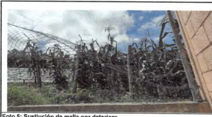
Foto 5: Sustitución de malla por deterioro
