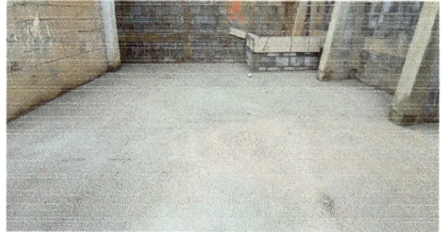
Foto 2: Renglón 7: La cocina fue pavimentada.
