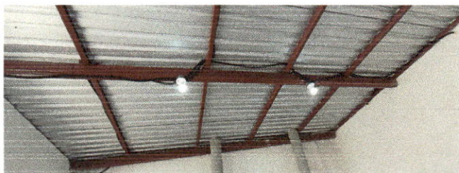
Foto 3: Renglón 2: Se colocaron vigas de metal para mayor duración y seguridad del techado de la cocina.
