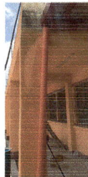
Foto 4: Renglón 3: Se colocaron tubos de pvc para la bajada de agua, en caso de lluvias.
