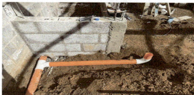
Renglón 6: colocación de tubería el cual trasportara las aguas negras a los drenajes.
