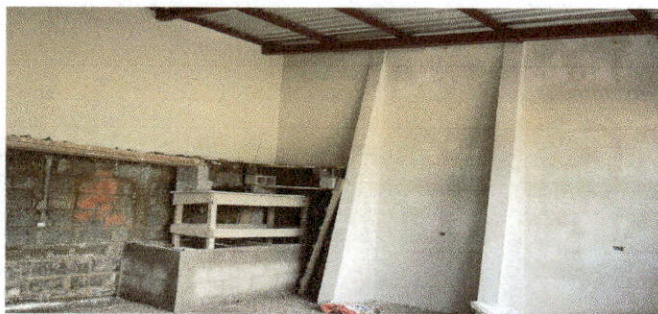
Renglón 12: repello para cubrir las paredes y evitar humedad dentro de la cocina.
