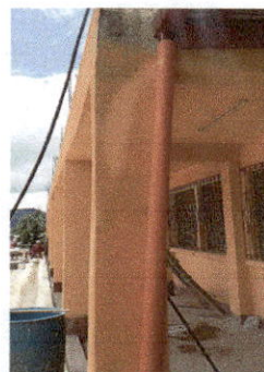
Renglon 3: Sustitución de canales para bajada de agua.
