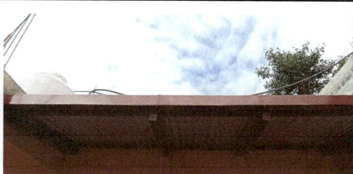
Renglon 3: Sustitución de canales con canales de metal.
