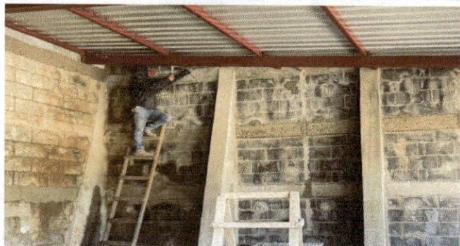
Renglon 1: colocación de laminas troqueladas las cuales tienen mayor resistencia a las condiciones climáticas y por el lugar a utilizar.
