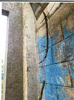
Foto 5: Renglón No. 12. Como se puede observar la pared necesita repello y cernido.
