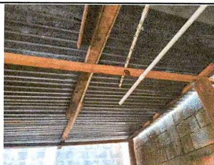
Foto 4: Renglón No. 2. Estructura de techo.
