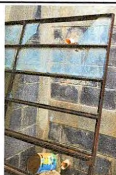
Foto 6: Renglón No. 10. Como se muestra en la fotografía las ventanas ya estan muy deterioradas.
