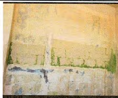
Foto 6: Renglón No. 4. Como se puede observar se filtra el agua en la pared por ello es importante la sustitución de pintura impermeable.
