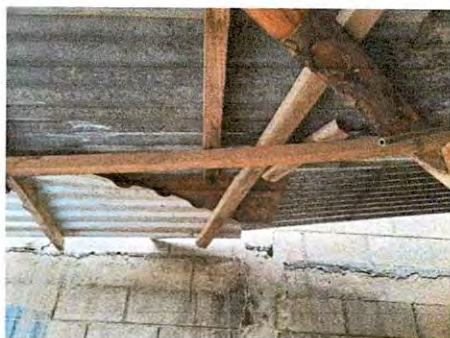
Foto 5: Renglón No. 2. Es importante la sustitución de la estructura de techo debido a que el actual es inseguro por las enmiendas que tiene.
