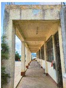
Foto 1: Renglón No. 13 Reparación en sistema eléctrico en Módulo 1
