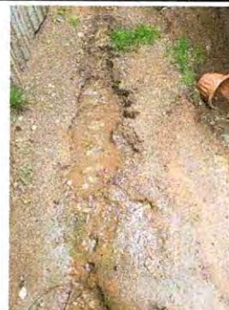
Foto 6: Como se puede observar hace falta la reparación de drenaje ya que se reposa el agua.
