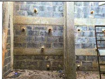
Foto 6: Renglón No. 12. Es necesario el repello y cernido de paredes de la cocina.
