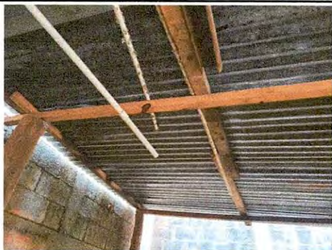
Foto1: Renglón No. 1 Cubierta de láminas
