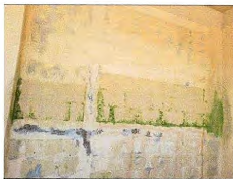
Foto 4: Renglón No. 12. Reparación de repello y cernido de paredes.
