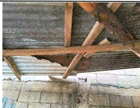
Foto 2: Renglón No. 1. Como se puede observar la lámina ya está deteriorada por lo cual es necesario la sustitución.
