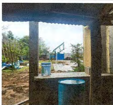
Foto 3: Renglón No. 3. Como se puede observar hace falta la instalación de canales para el agua pluvial.
