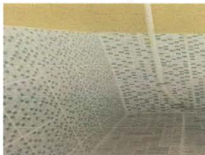
COLOCACIÓN DE AZULEJO
