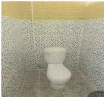
CAMBIO DE TAZAS SANITARIAS
