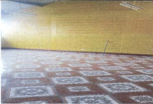
cambio de piso en aulas
