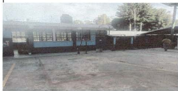
PINTURA EXTERIOR DE AULAS
