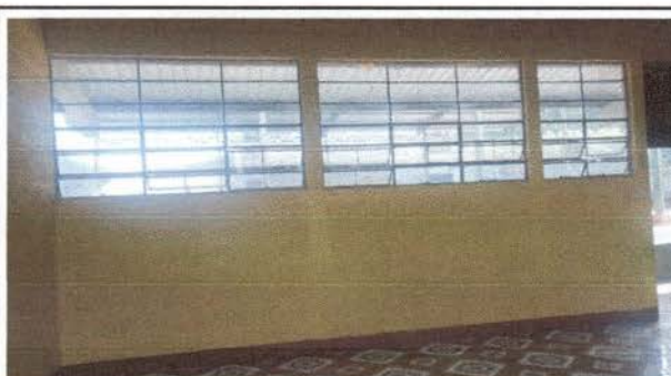
pintura interior de aulas
