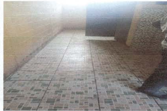
cambio de piso en sanitarios
