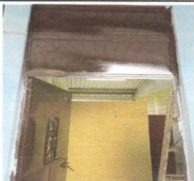
Pintura y reparación de puertas
