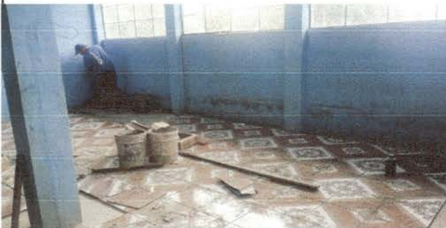
cambio de piso en aulas
