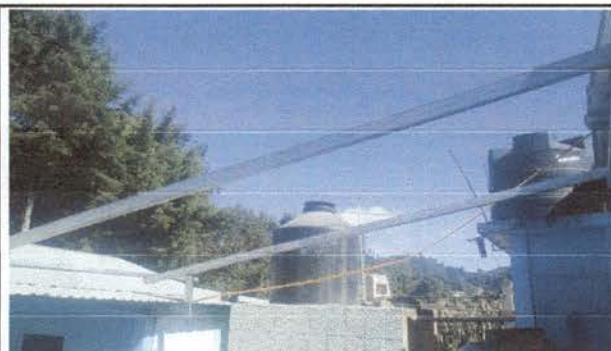
elaboracion de techado de media agua
