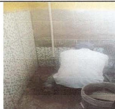
colocación de azulejo en sanitarios
