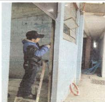
Reparacion de puertas
