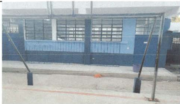
elaboracion y colocación de balcones
