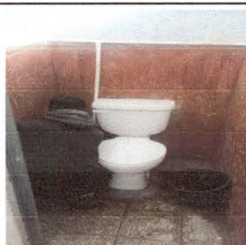
inicio de cambio de piso
