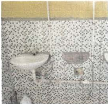
Compra e instalación de lavamanos
