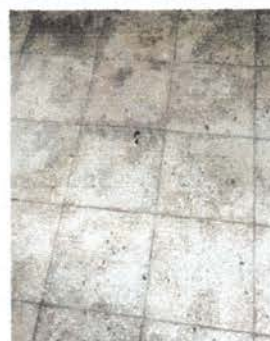
cambio de piso en sanitarios
