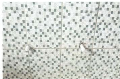
reparacion y colocación de chorros faltantes en lavamanos
