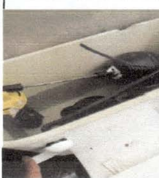
reparación de sanitarios
