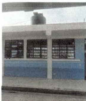
elaboración e instalación de barandas
