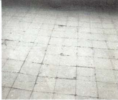
cambio de piso en dos aulas
