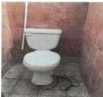
cambio de tazas sanitarias en mal estado
