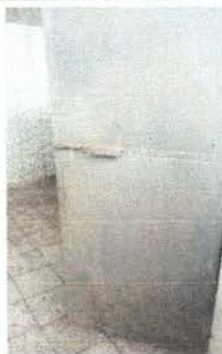
reparacion y pintura de puertas de sanitario
