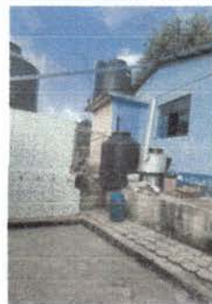
colocacion de techado de corredor
