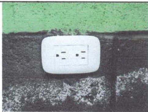
Foto 5: Cambio de tomacorrientes en mal estado.
