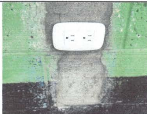
Foto 4: Cambio de cajas rectangulares en mal estado.
