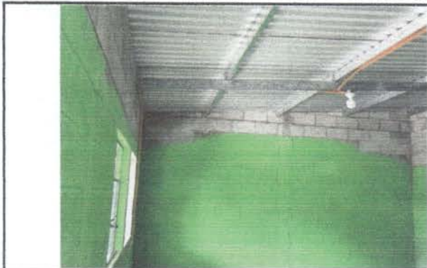
Foto1: Cambio de lámina y estructura de soporte.
