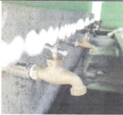
Foto 1: Cambio de chorros sencillos por unos de mejor calidad, algunos ya no cierran el paso de agua.
