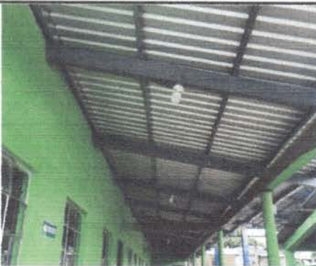
Foto 3: Cambio de soporte, específicamente costanera de madera a costanera galvanizada para dos salones.
