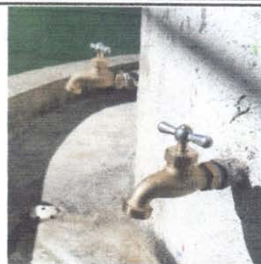
Foto 2: Cambio de chorros en mal estado y colocación de otros que ya no tienen.
