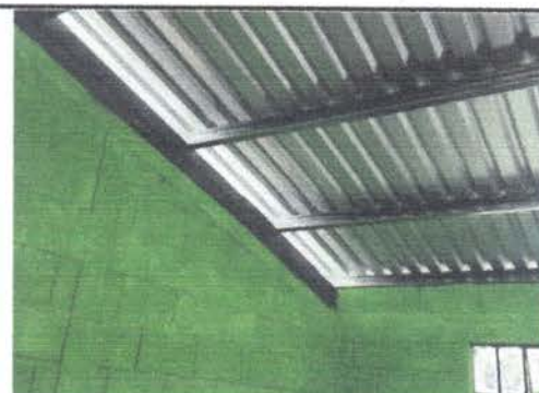
Foto 6: La lámina está picada, requiere cambio.
