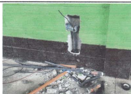
Foto 4: Cambio de cajas rectangulares en mal estado.
