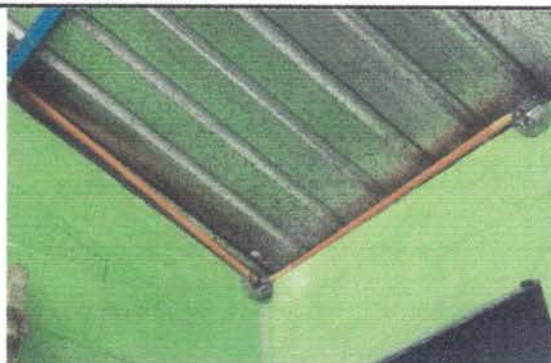
Foto 6: Cambio de ductos y cajas octogonales.
