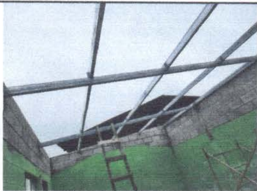
Foto1: Cambio de lámina y estructura de soporte.
