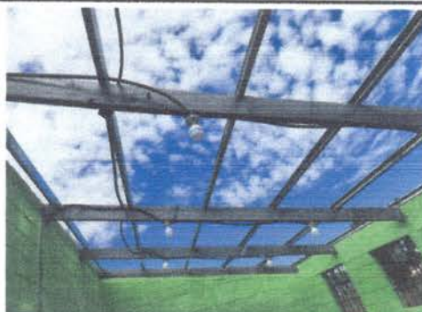
Foto 6: La lámina está picada, requiere cambio.
