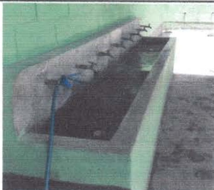
Foto 1: Cambio de chorros sencillos por unos de mejor calidad, algunos ya no cierran el paso de agua.
