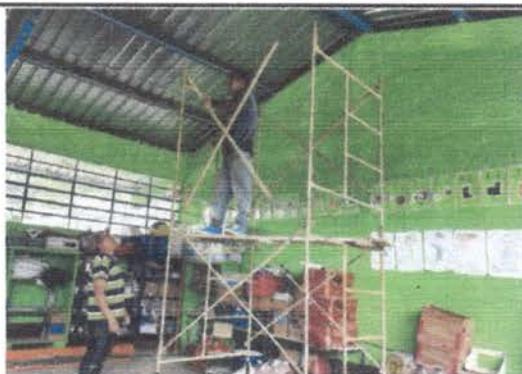
Foto 3: Cambio de candelas y sujetadores por plafoneras y focos led.
