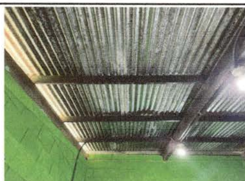
Foto 6: La lámina está picada, requiere cambio.
