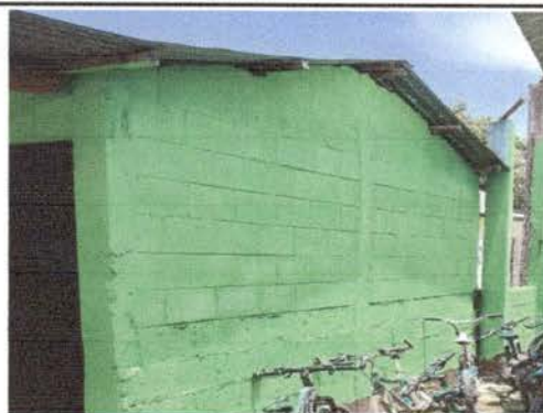
Foto 2: Cambio de forma de techo de 2 aguas a una, ya que la caída de agua en la parte de atrás del salón humedece la pared interior.
