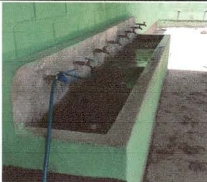
Foto 1: Cambio de chorros sencillos por unos de mejor calidad, algunos ya no cierran el paso de agua.
