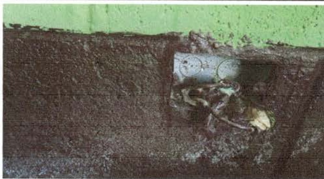
Foto 5: Cambio de tomacorrientes en mal estado.
