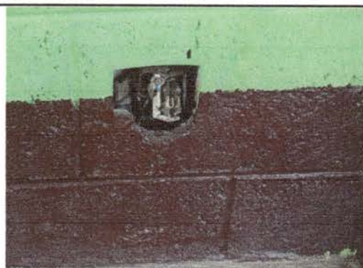
Foto 4: Cambio de cajas rectangulares en mal estado.
