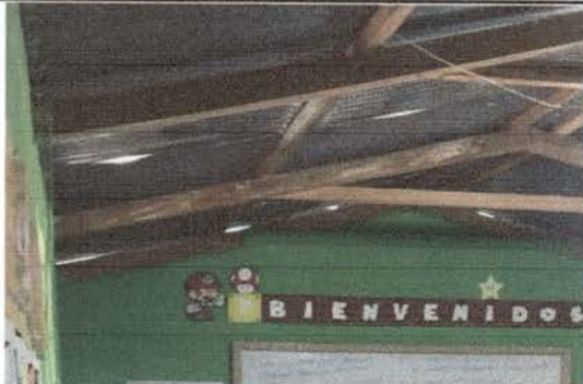
Foto1: Cambio de lámina y estructura de soporte.
