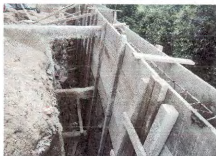
Foto 3: Reparación del muro de contención
