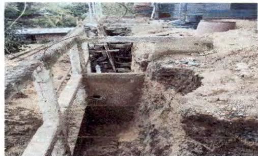
Foto 2: Muro de contención en reparación
