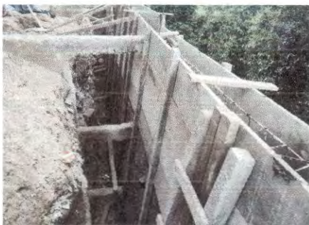
Foto 3: Reparación del muro de contención
