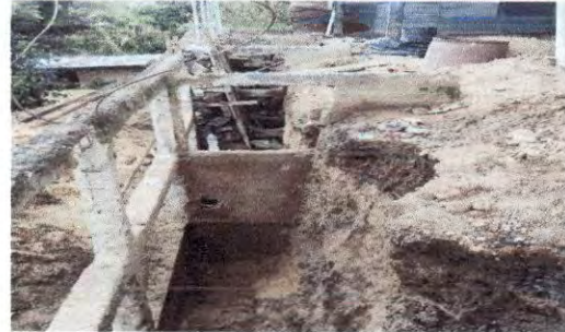
Foto 2: Muro de contención en reparación
