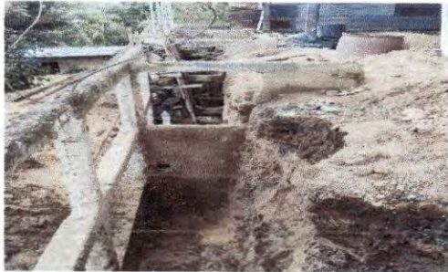
Foto 1: Muro de contención en reparación
