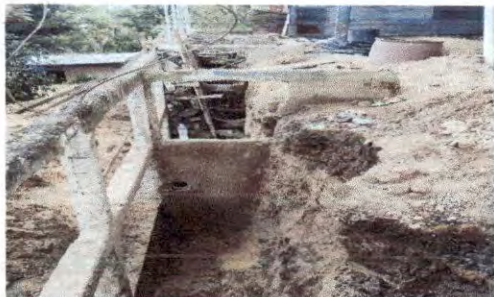
Foto 1: Muro de contención en reparación
