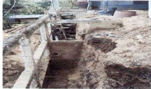
Foto 2: Muro de contención en reparación
