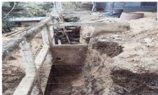
Foto 2: Muro de contención en reparación
