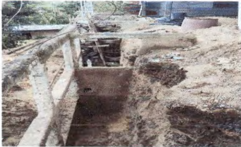
Foto 1: Muro de contención en reparación
