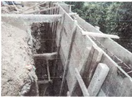
Foto 3: Reparación del muro de contención
