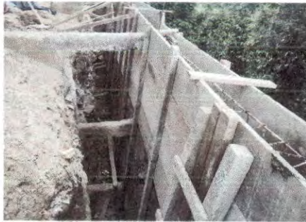
Foto 3: Reparación del muro de contención
