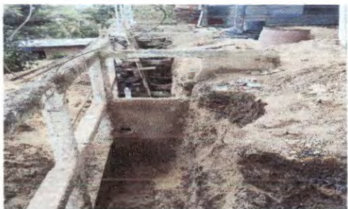
Foto 1: Muro de contención en reparación
