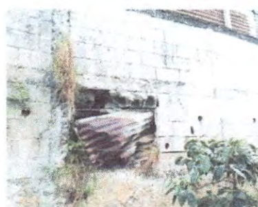
Foto 2: Reparación de muro de contención
