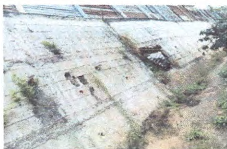
Foto 1: Reparación de muro de contención
