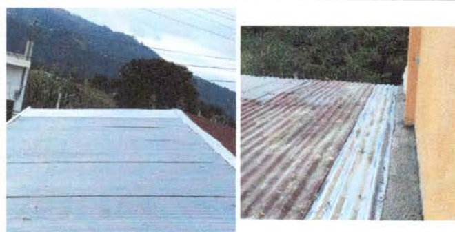
Foto 5: Reparación de láminas en 2 salones.
