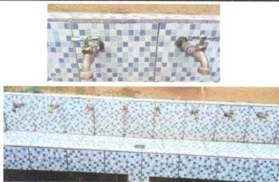
Foto 13: Reparación de chorros de lavamanos.
