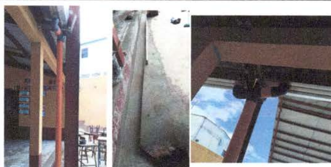
Foto 4: Incorporación de canales de agua.
