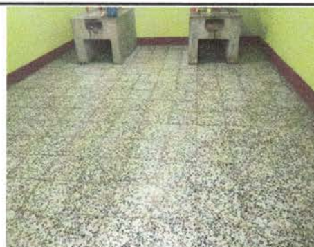
Foto. 6 Cambio de piso en cocina.
