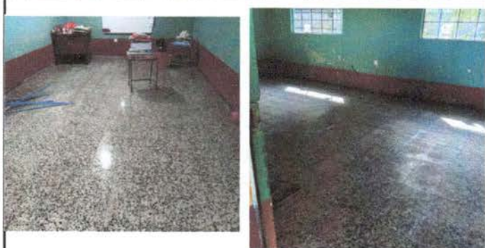
Foto1: Cambio de Piso en 2 salones.
