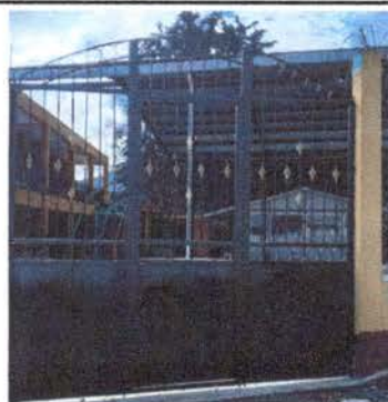
Foto 2: Cambio de portón
