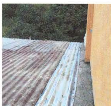
Foto 5: Reparación de láminas en 2 salones.
