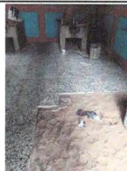
Foto. 6 Cambio de piso en cocina.
