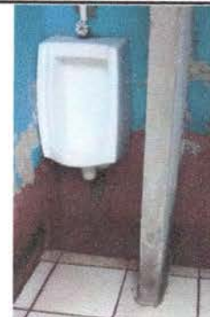
Foto 10: Arreglo de sanitarios, no tienen accesorios para echar agua. En mingitorios una pared divisoria.
