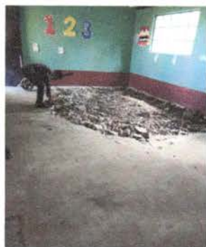
Foto1: Cambio de Piso en 2 salones.
