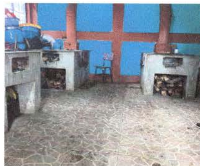
Foto. 6 Cambio de piso en cocina.
