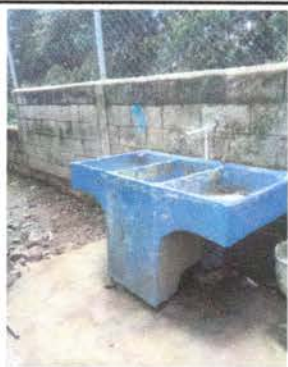
Foto 9: Incorporación de 2 sanitarios en esta área.
