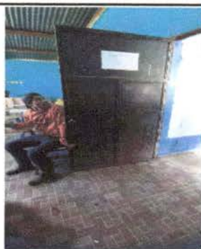
Foto 11: Reparación de puerta y cambio de piso.
