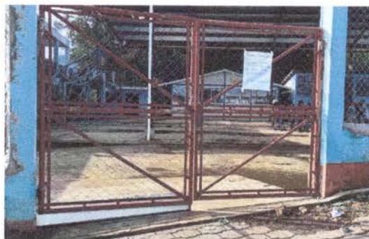
Foto 2: Cambio de portón
