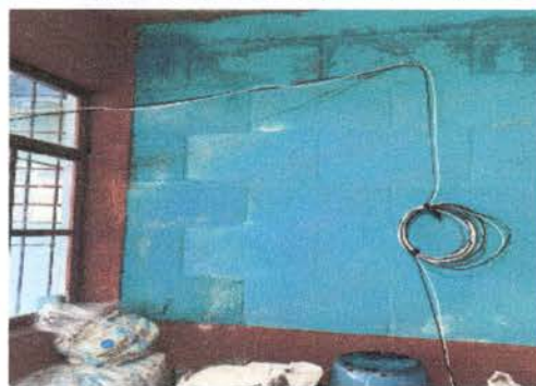
Foto 8: Pintado de cocina y reparación de electricidad.
