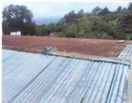
Foto 5: Reparación de láminas en 2 salones.
