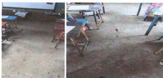
Foto1: Cambio de Piso en 2 salones.
