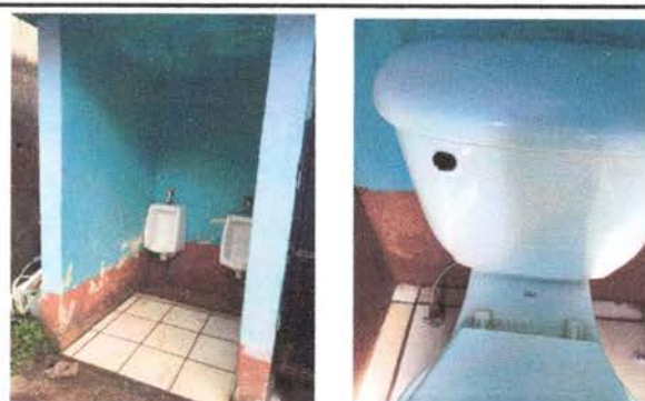
Foto 10: Arreglo de sanitarios, no tienen accesorios para echar agua. En mingitorios una pared divisoria.
