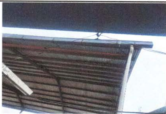
Foto 3: El tendido eléctrico está en mal estado. Se debe cambiar por cortos circuitos que ha habido en toda la escuela.
