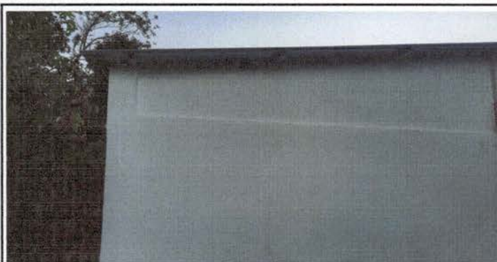
Foto 2: Repello de paredes
