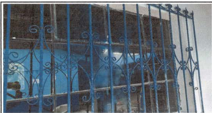
Foto 4: Balcones en ventanas.
