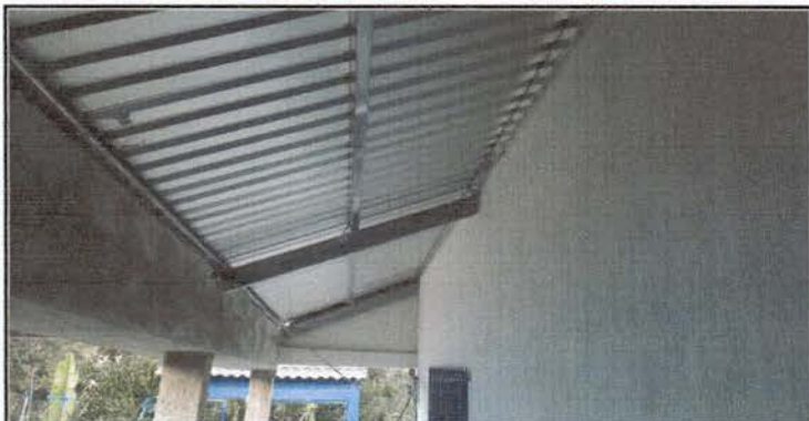
Foto1: Canaleta de concreto y techo de corredor
