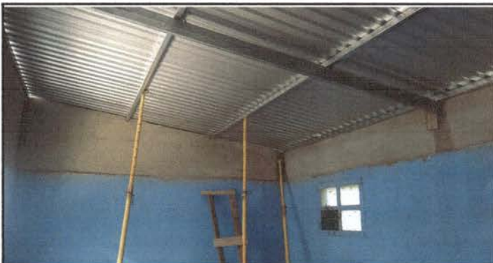
Foto 4: Colocación de vigas y costaneras.
