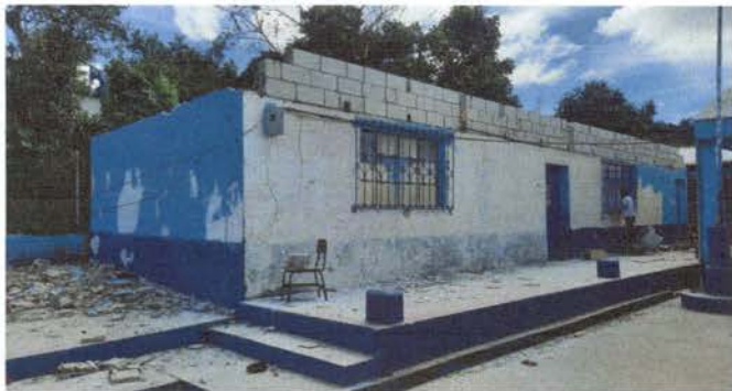
Foto1: Preparación de espacio para empezar los trabajos.
