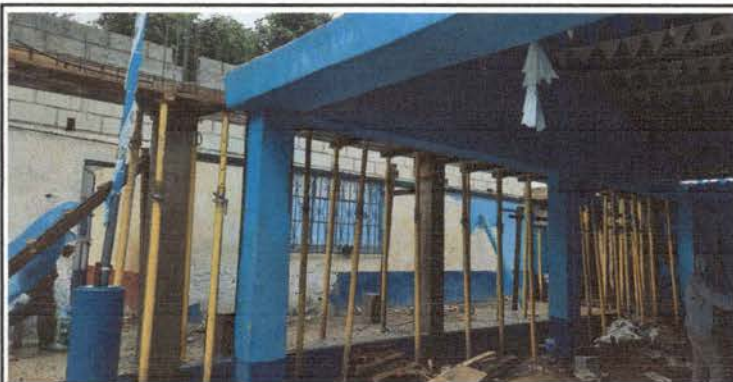
Foto 3: Fundición de canaleta de concreto.
