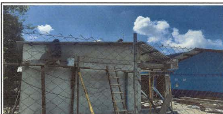
Foto 6: repello de paredes.
