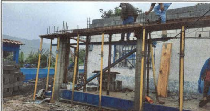
Foto 2: Colocación de bases para canaleta de concreto.
