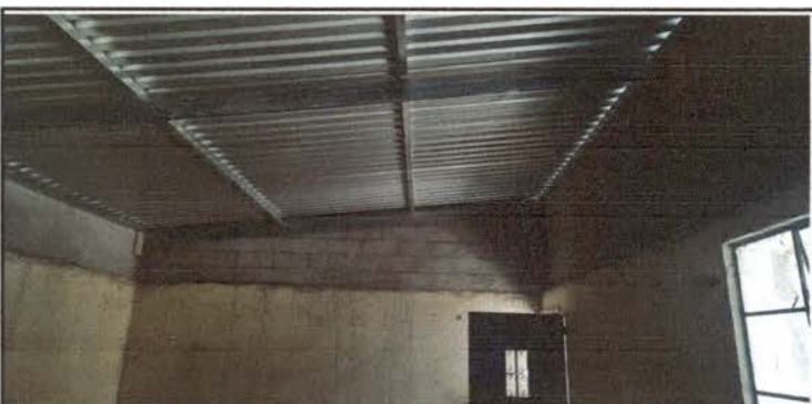
Foto 5: Finalización de techado.
