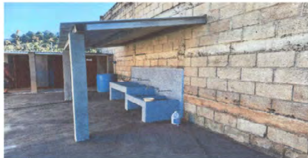
Foto 6: ampliación de pilas -abajo
