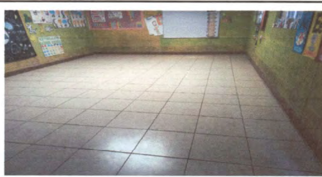
Foto 6: colocación de piso aula No. 20 atrás
