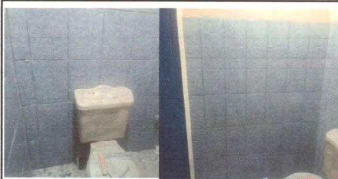
Foto 5: cambio de accesorios de baño de maestros y colocación de azulejos No. 7
