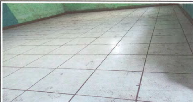
Foto 2: colocación de piso aula No. 22 atrás
