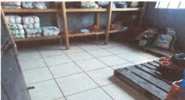
Foto 3: colocación de piso de bodega de cocina
