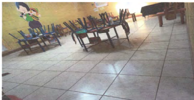
Foto1: colocación de piso aula No. 21 atrás
