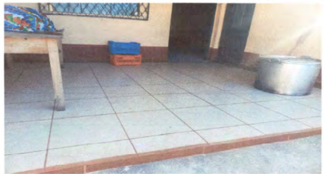
Foto 2: colocación de piso cooredor de cocina
