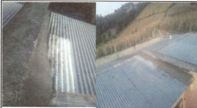
Foto1: arreglo de techo de lámina aula No. 3
