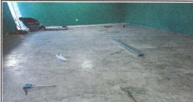
Foto 2: colocación de piso aula No. 22 atrás
