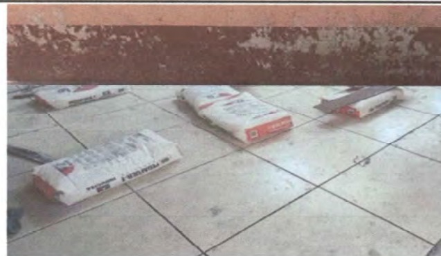
Foto 2: colocación de piso cooredor de cocina
