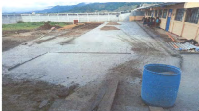
Foto 1: pavimento frente a las aulas
