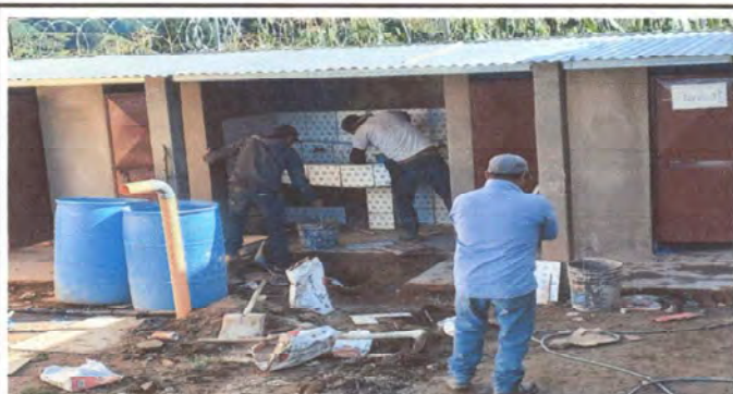
Foto 4: colocación de piso y azulejo en sanitario -abajo
