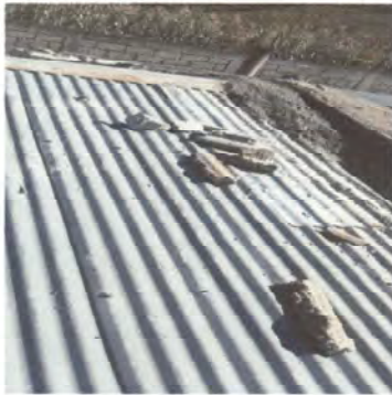
Foto1: arreglo de techo de lámina aula No. 3
