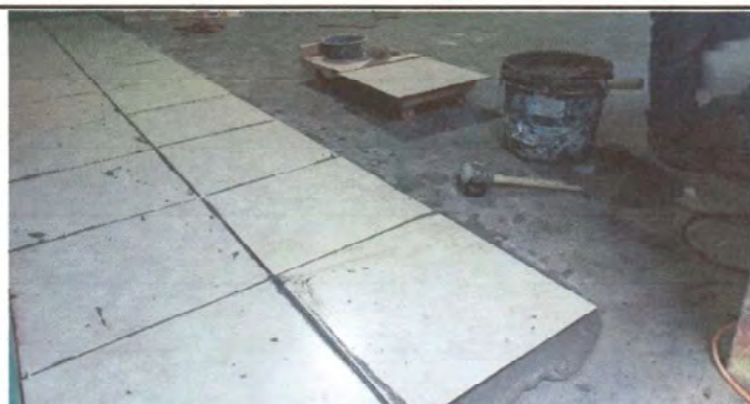
Foto 3: colocación de piso de bodega de cocina
