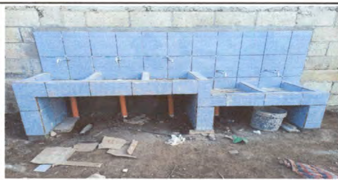
Foto 6: ampliación de pilas -abajo
