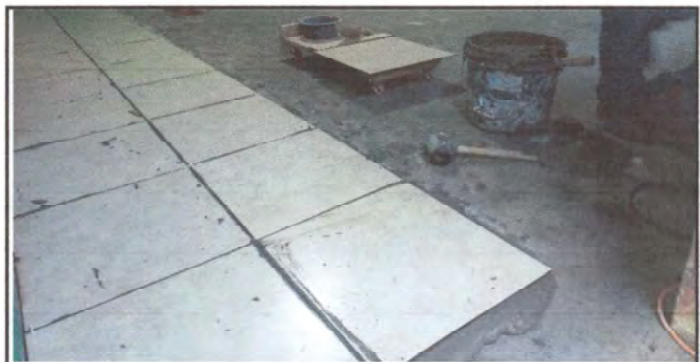
Foto 6: colocación de piso aula No. 20 atrás
