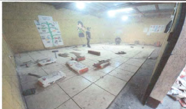
Foto1: colocación de piso aula No. 21 atrás
