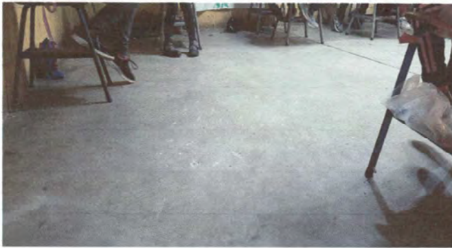
Foto1: colocación de piso aula No. 21 atrás
