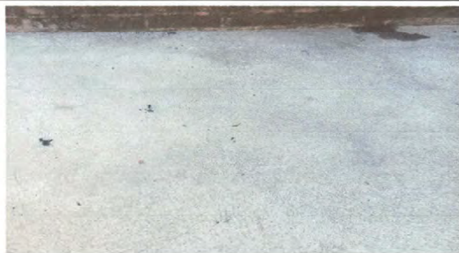
Foto 3: colocación de piso de bodega de cocina
