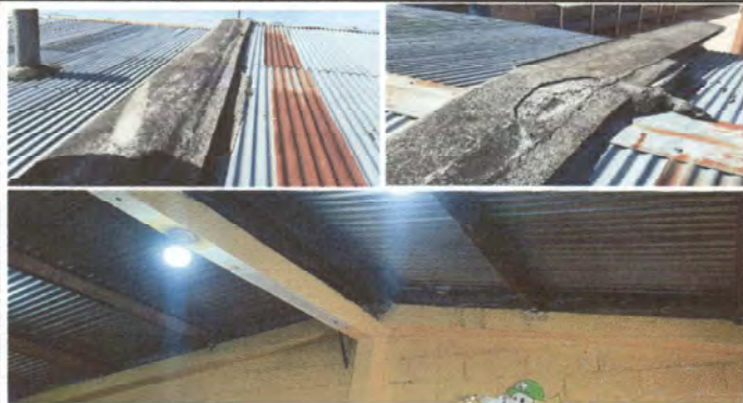
Foto1: arreglo de techo de lámina aula No. 3
