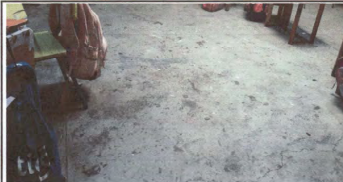
Foto 6: colocación de piso aula No. 20 atrás
