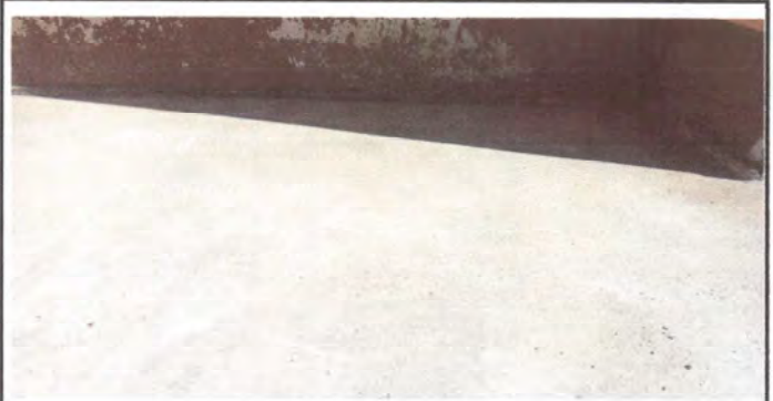
Foto 2: colocación de piso cooredor de cocina
