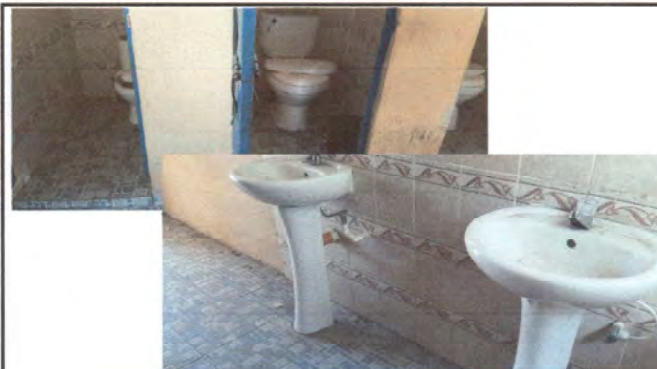
Foto 4: cambio de accesorios de sanitarios y cambio de lavamanos mujeres No. 8
