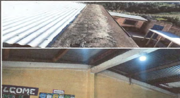
Foto 2: arreglo de techo de lámina aula No. 18
