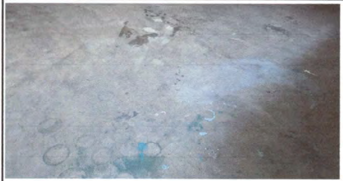
Foto 2: colocación de piso aula No. 22 atrás
