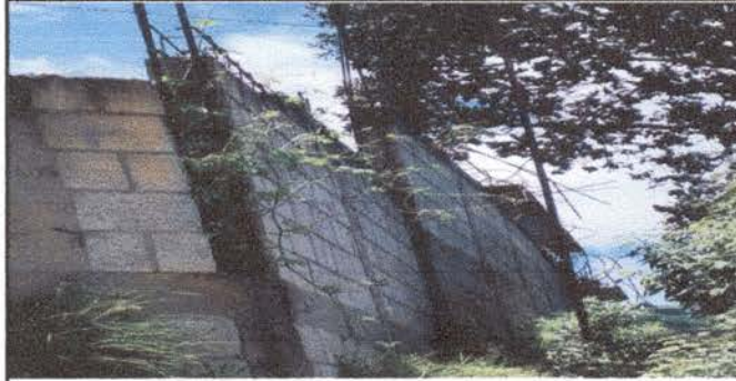
Foto 6: se colocará sobre la pared malla galvanizada, para el resguardo y seguridad de las instalaciones de la Escuela. Esta pared es continuación de donde se desarrollará el remozamiento.
