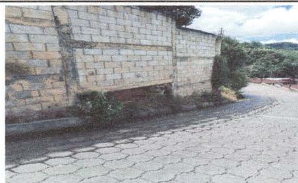
Foto 4: Vista en la segunda parte externa de la pared, se observa también perdida en la parte baja de la pared, foto 3 y 4 representa peligro para la comunidad educativa y posible colapso del total de la pared.
