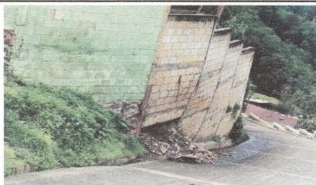
Foto 3: Vista en la primera parte externa de la pared, se observa humedad, perdida de la pared en la parte baja de la pared.
