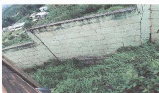
Foto 2: Parte interna superior, la pared que esta en malas condiciones en la parte baja.
