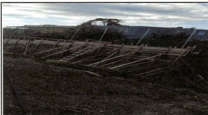
BAJADA DE LA ORILLA DEL TERRENO
