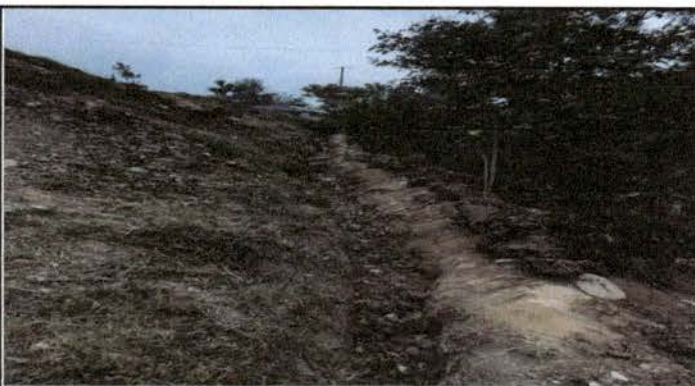
BAJADA DE LA ORILLA DEL TERRENO
