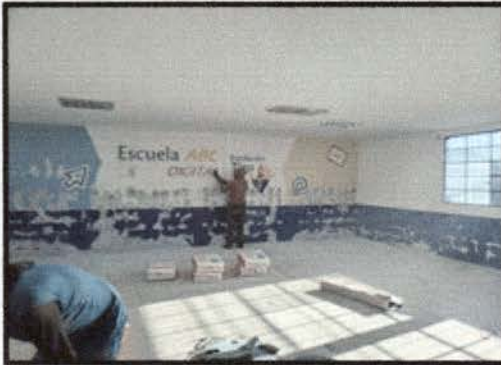
Foto 7: Reparación de repello y cernido de paredes
