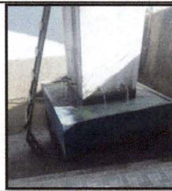
Foto 10: Reparación y mantenimiento de cisterna / lavamanos
