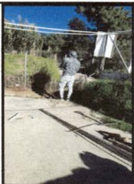
Foto 3: Cerco o muro perimetral
