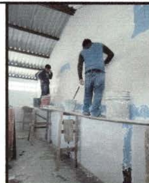
Foto 6: Reparación de repello y cernido de paredes
