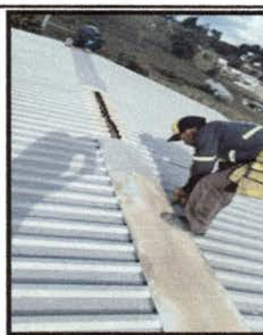
Foto 4: Cambio de techo en salón
