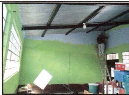
Foto 2: Pintado de aulas
