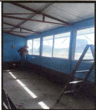
Foto 1: Mantenimiento de ventanas corredizas
