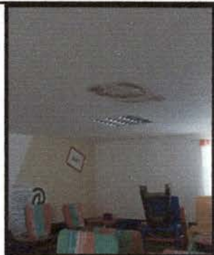
Foto 5: Reparación y mantenimiento de cielo falso
