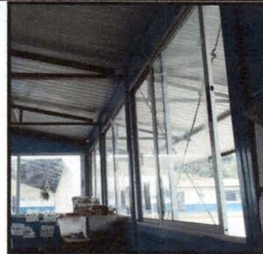
Foto 4: Mantenimiento de ventanas corredizas
