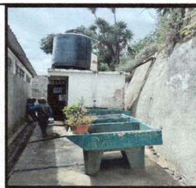
Foto 12: Reparación y sustitución de pilas
