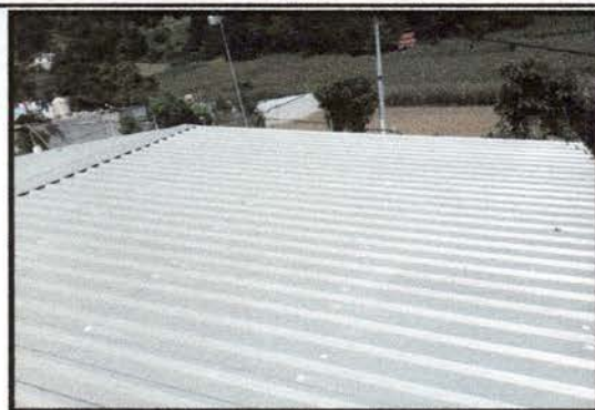
Foto 8: Cambio de techo en aula
