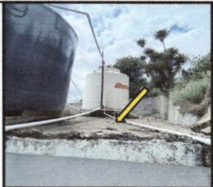
Foto7: Reparación de tubos de agua
