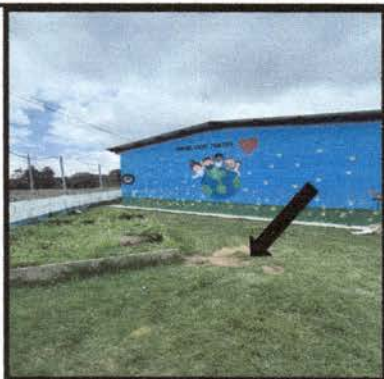
Foto 9: Limpieza de fosa septica
