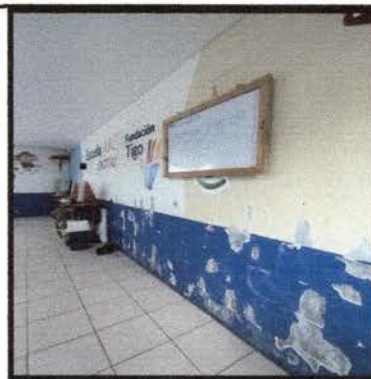
Foto 10: Reparación de repello y cernido de paredes
