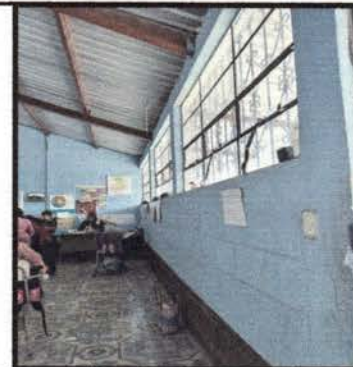
Foto 6: Reparación de repello y cernido de paredes
