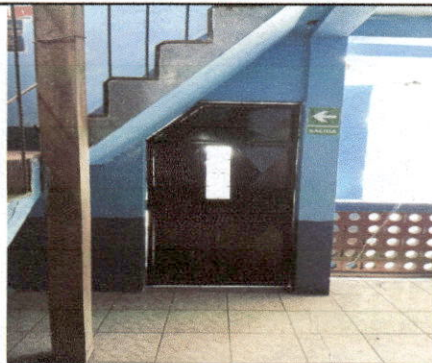
Foto 11: Puerta recortada que se traslado del aula de segundo al pasillo.
