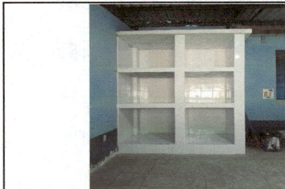
Foto1: realización de trinchante de concreto con azulejo en la cocina.
