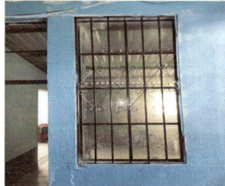
Foto 8: Elaboración de balcón para ventana en la cocina para resguardo de insumos.
