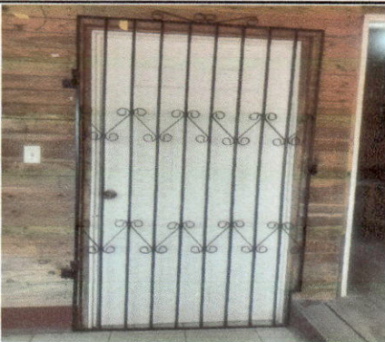
Foto 9: Elaboración de reja de metal para puerta.
