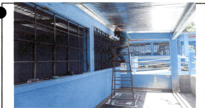
Foto 5: Colocación de balcones
