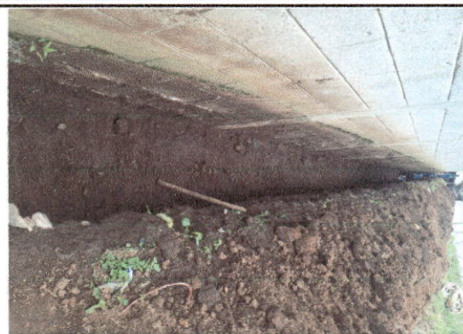
Foto 2: Zanjeado detrás de las aulas para cernir y evitar la humedad
