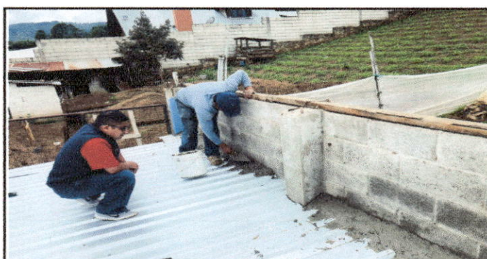
Foto 6: Colocación de cemento entre pared y lámina para evitar filtración de agua pluvial
