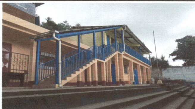
Foto 3: Pintura en paredes de las aulas interiores y exteriores
