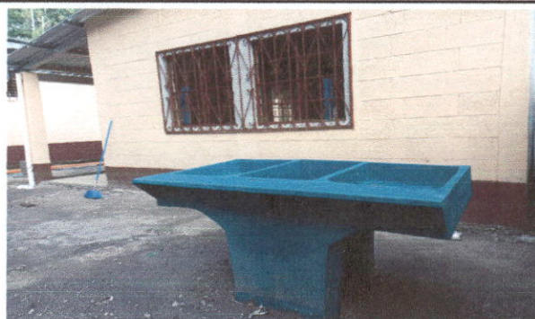
Foto 6: Colocación de pila de concreto a la par de la cocina ampliada
