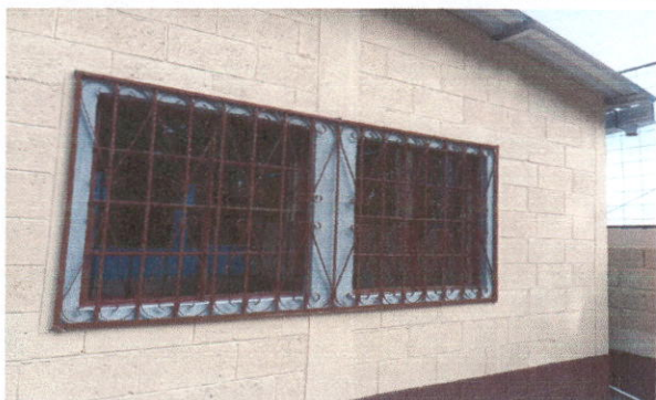
Foto1: Ventanas estructura de metal con vidios incluidos y el balcon de protección
