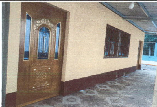
Foto 2: Puertas de la cocina colocadas, al igual que los balcones
