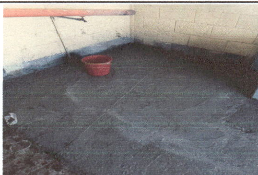
Foto 6: Lugar donde el agua pluvial se estancaba, y ahora se rellenó y el agua corre al drenaje pluvial correspondiente.
