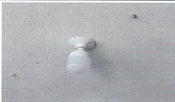
Foto 5: Sustitución de candelas, por focos led en dos aulas
