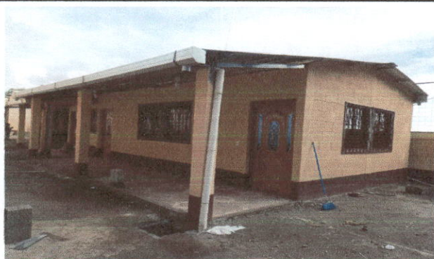
Foto1: Cocina ampliada finalizada y pintada
