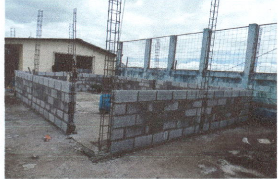
Foto 2: Avance de la ampliación de cocina
