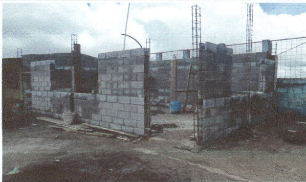
Foto 3: Avance a,pliación de cocina
