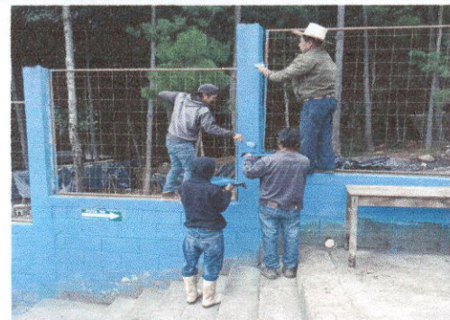
Foto 6: Pintura en paredes circulación de la escuela
