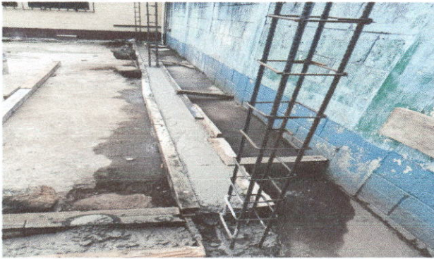
Foto1: Inicios de los trabajos de ampliación de cocina
