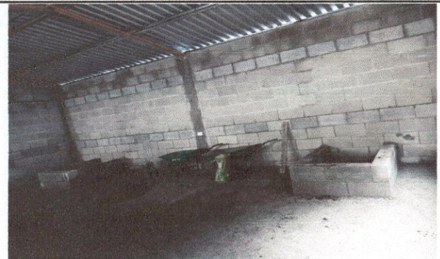
Foto 4: Construcción de 2 poyetones (estufas mejoradas de leña)
