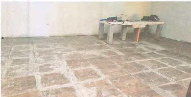
Terminación de piso con su respectiva sisa.
