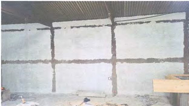
paredes del interior de la cocina
