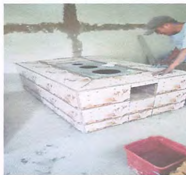
Colocación de azulejo.
