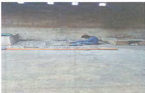
Construcción del nuevo pollo.
