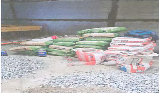
Material para colocación de piso de la cocina.
