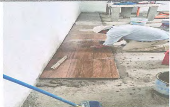
Colocación de piso.
