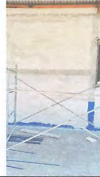
repello de las paredes de la cocina
