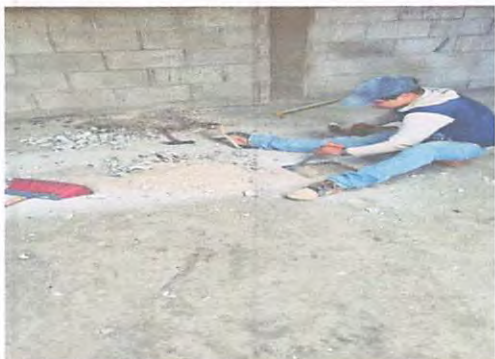
Construcción del nuevo pollo.
