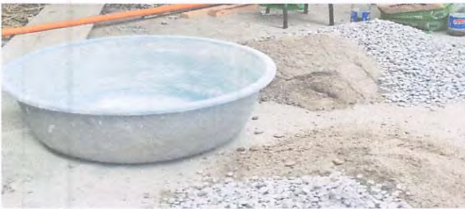
Mezcla para la nueva torta, antes de colocar el piso.
