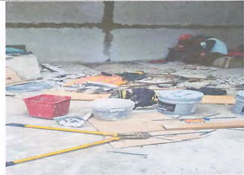
Levantado y picado de torta.
