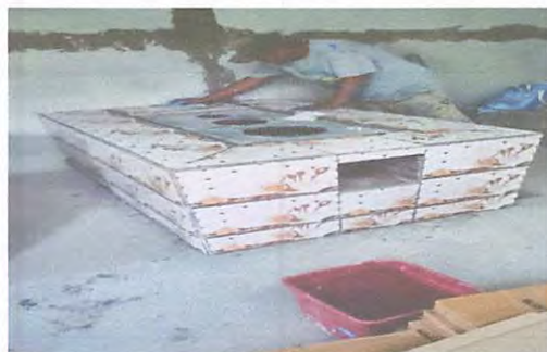
Colocación de nuevas planchas.
