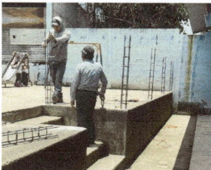
DURANTE CONSTRUCCIÓN DE BARANDA
