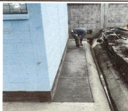
FINALIZACIÓN CONSTRUCCIÓN DE BANQUETA
