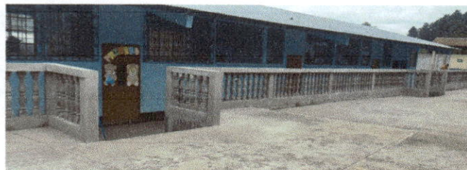
FINALIZACIÓN DE CONSTRUCCION DE BARANDA
