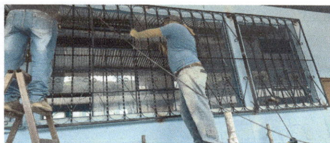
FINALIZACIÓN DE COLOCACION DE BALCONES
