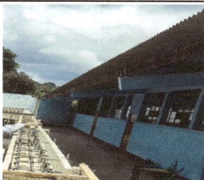
PREVIO A COLOCACIÓN DE BALCONES
