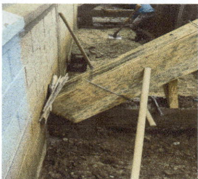
PREVIO A COLOCACIÓN DE BALCONES
