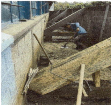
CONSTRUCCIÓN DE SOPORTE DE MURO
