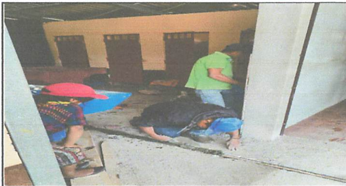
FOTO 2: DURANTE LA COLOCACION DE PISO CERAMICO DEL CORREDOR DE LA COCINA Y LOS BAÑOS
