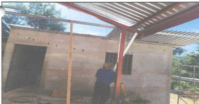
FOTO 5: DURANTE LA COLOCACION DE TECHADO DEL CORREDOR DE LA COCINA
