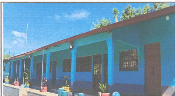
FOTO 10 DURANTE LA PINTADA DE LAS AULAS, COCINA Y MURO DEL CORREDOR
