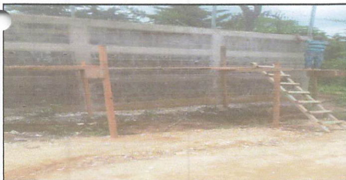
FOTO 11: DURANTE LA AMPLIACION DE MALLA PARA EL MURO DE LA CALLE
