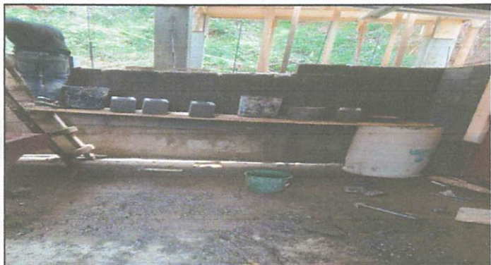
FOTO 3: DURANTE LA ELABORACION DE LA BASE DE LOS TINACOS
