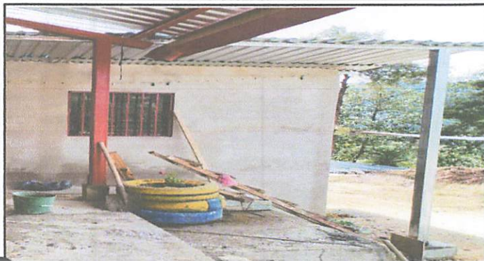
FOTO 7: DURANTE LA COLOCACION DE TUBOS GALVANIZADA PARA LA BAJADA DEL AGUA
