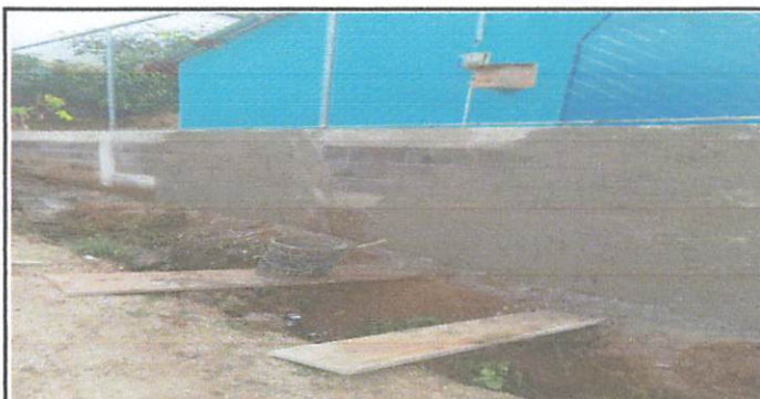
FOTO 12: DURANTE EL CERNIDO Y PINTADA DEL MURO DE LA CALLE PRINCIPAL
