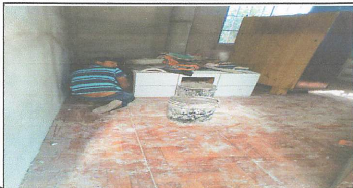
FOTO 1: DURANTE LA COLOCACION DE PISO CERAMICO EN LA COCINA
